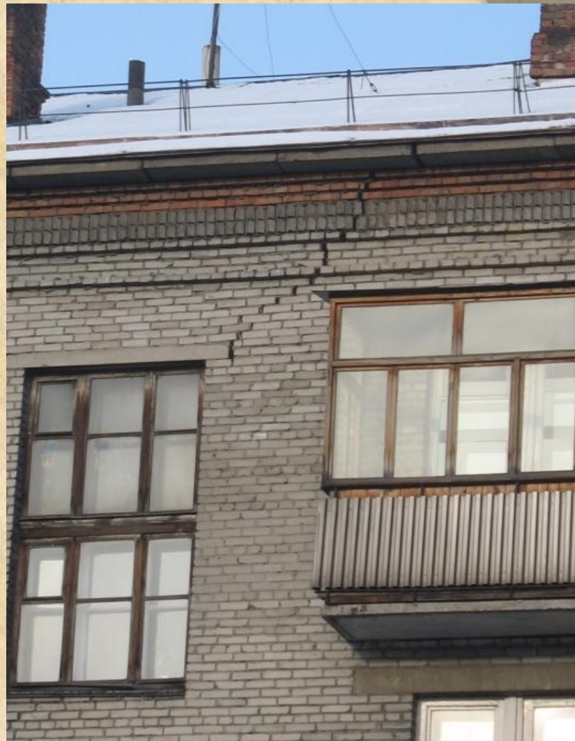
Рис. 4.6. Трещины в кирпичных стенах жилого дома по ул. Депутатская, 28
