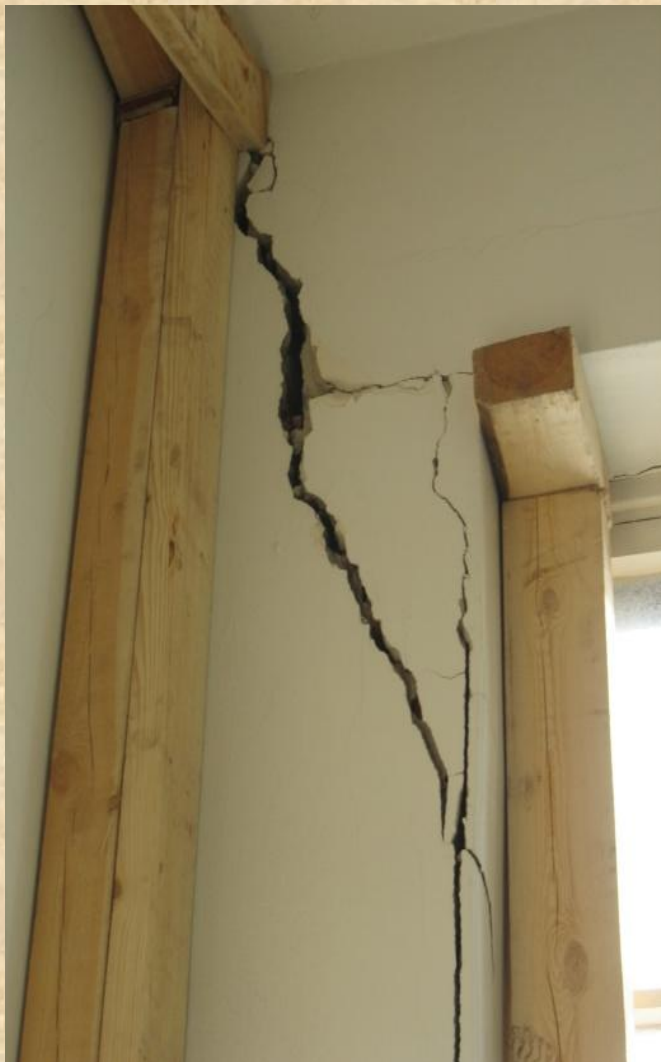
Рис. 4.6. Трещины в кирпичных стенах жилого дома по ул. Депутатская, 28
