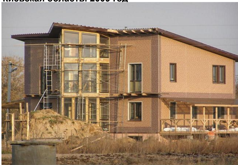
Дом облицован фасадными плитами
