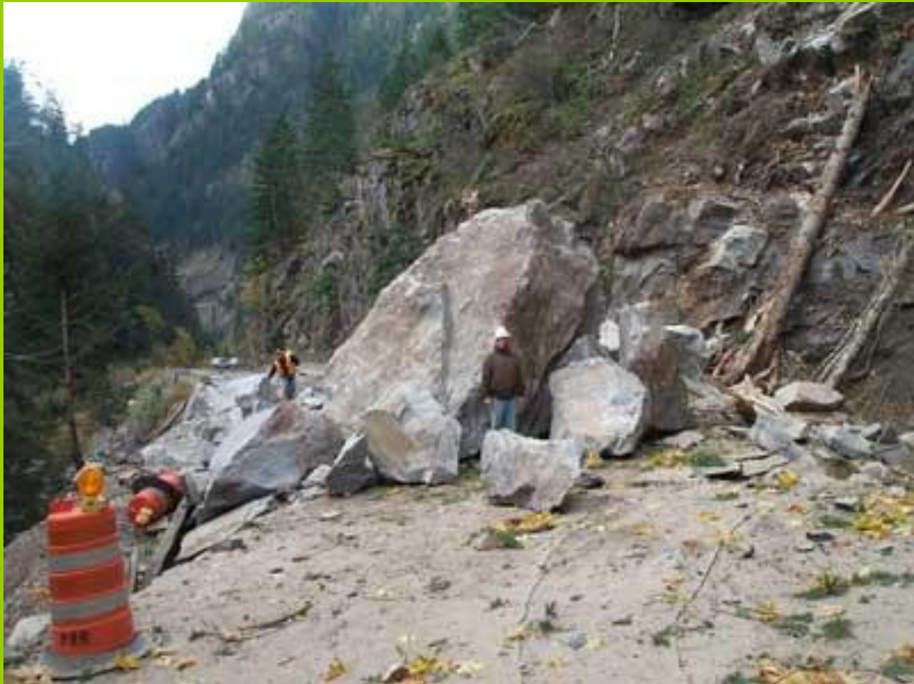
Вывал крупных глыб на дорогу, США, 2003 г.
