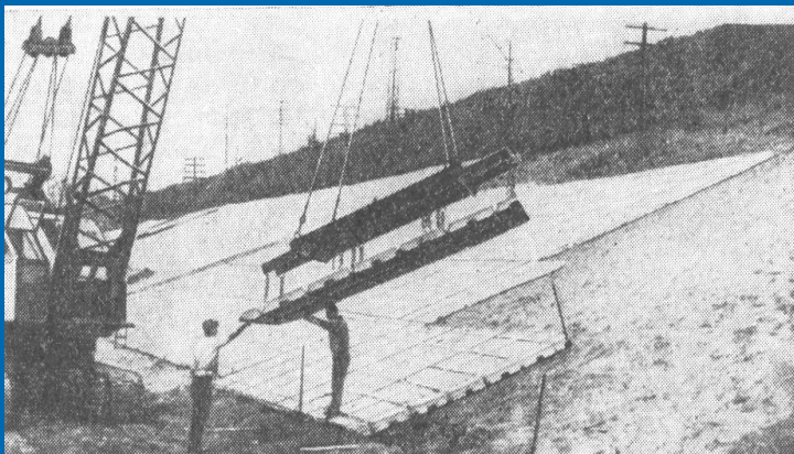
Укладка защитных плит
