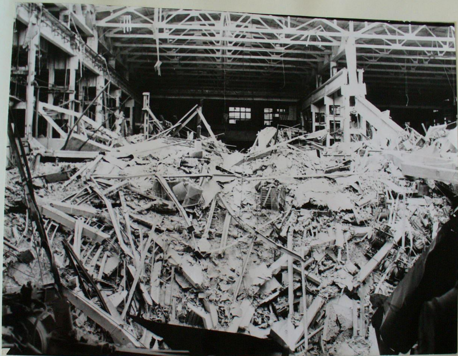
Провал в г. Дзержинске на НПО „Дзержинск Химмаш“ в корпусе 1 d=30\text{ м} , h \approx 10\text{ м} . 15 июля 1992г.
