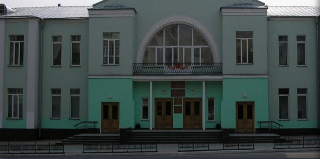
Музей истории Западно-Сибирской железной дороги
