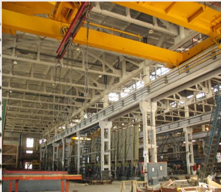
Рис.1.8. Конструктивные элементы в сборном исполнении
