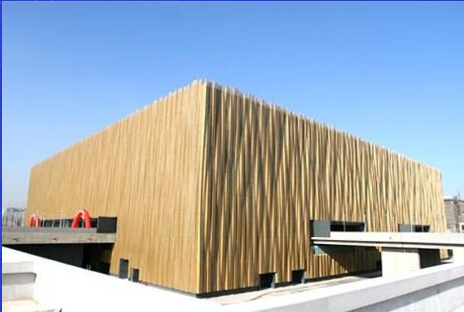
**Построен к Олимпиаде-2008.** Внешняя отделка фасадов состоит из гигантских пластин из специального алюминиевого сплава, меняющего свой цвет в зависимости от освещения и времени суток (от золотого днем до неона-зеленого ночью).
