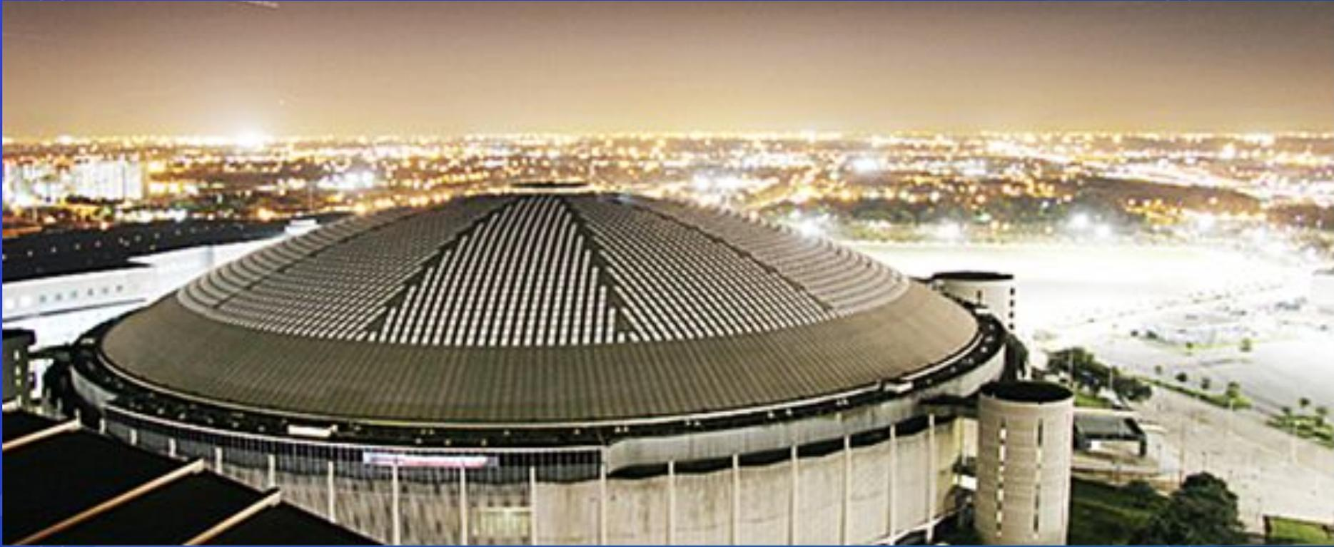
Первый в мире полностью крытый стадион был построен в Хьюстоне в **1965г.** Светопрозрачная конструкция в виде купола с высотой **70** м и диаметром **215**м сделала пространство стадиона замкнутым.
