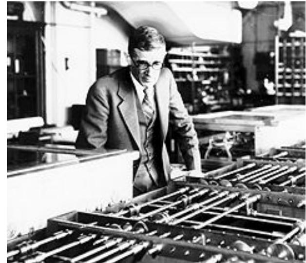
Наиболее совершенной электромеханической аналоговой вычислительной машиной был дифференциальный анализатор Ванневара Буша (Bush, Vannevar; 1890-1974) в Массачуссетском технологическом институте (1931 г.)
