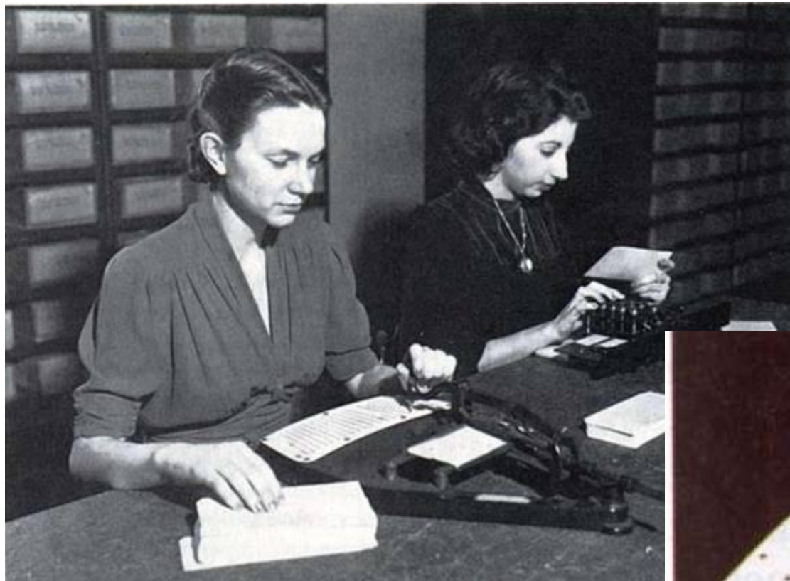
Пробивка отверстий в перфокарте Холлерита
