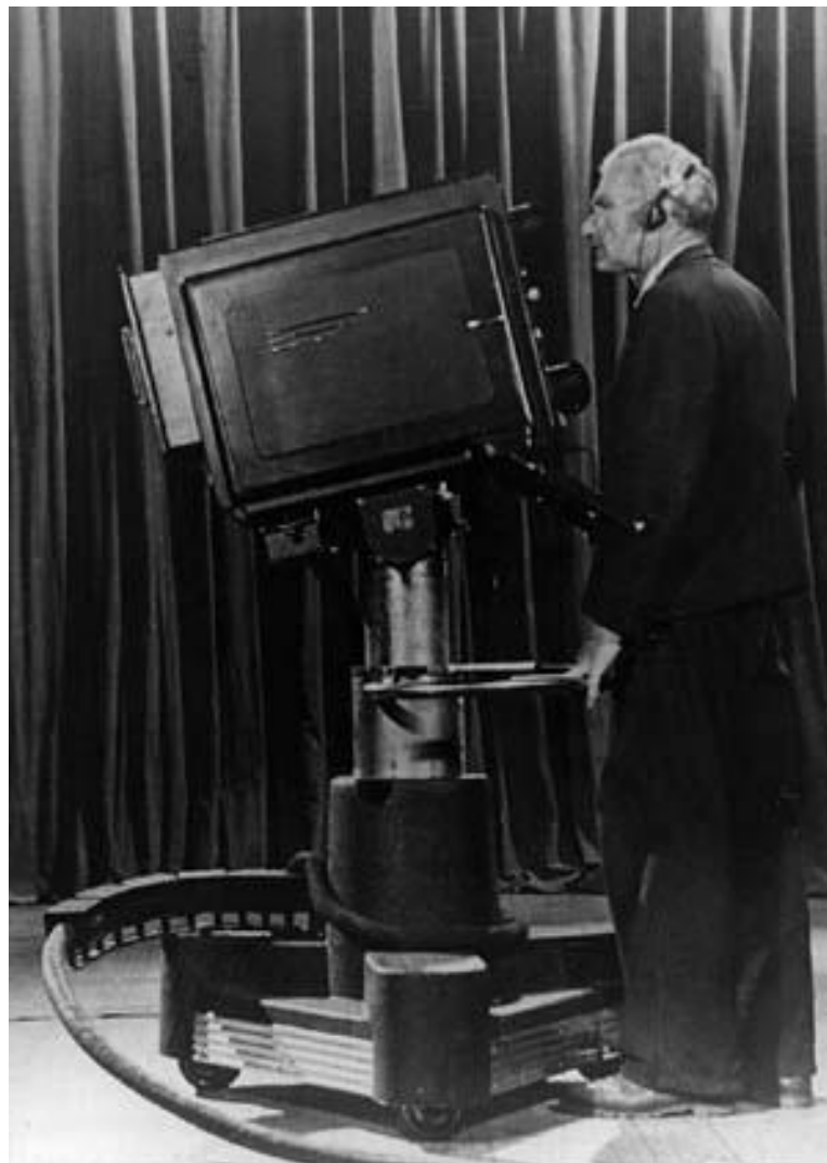
Телевизионная камера на иконоскопе. Архив НИИТ
