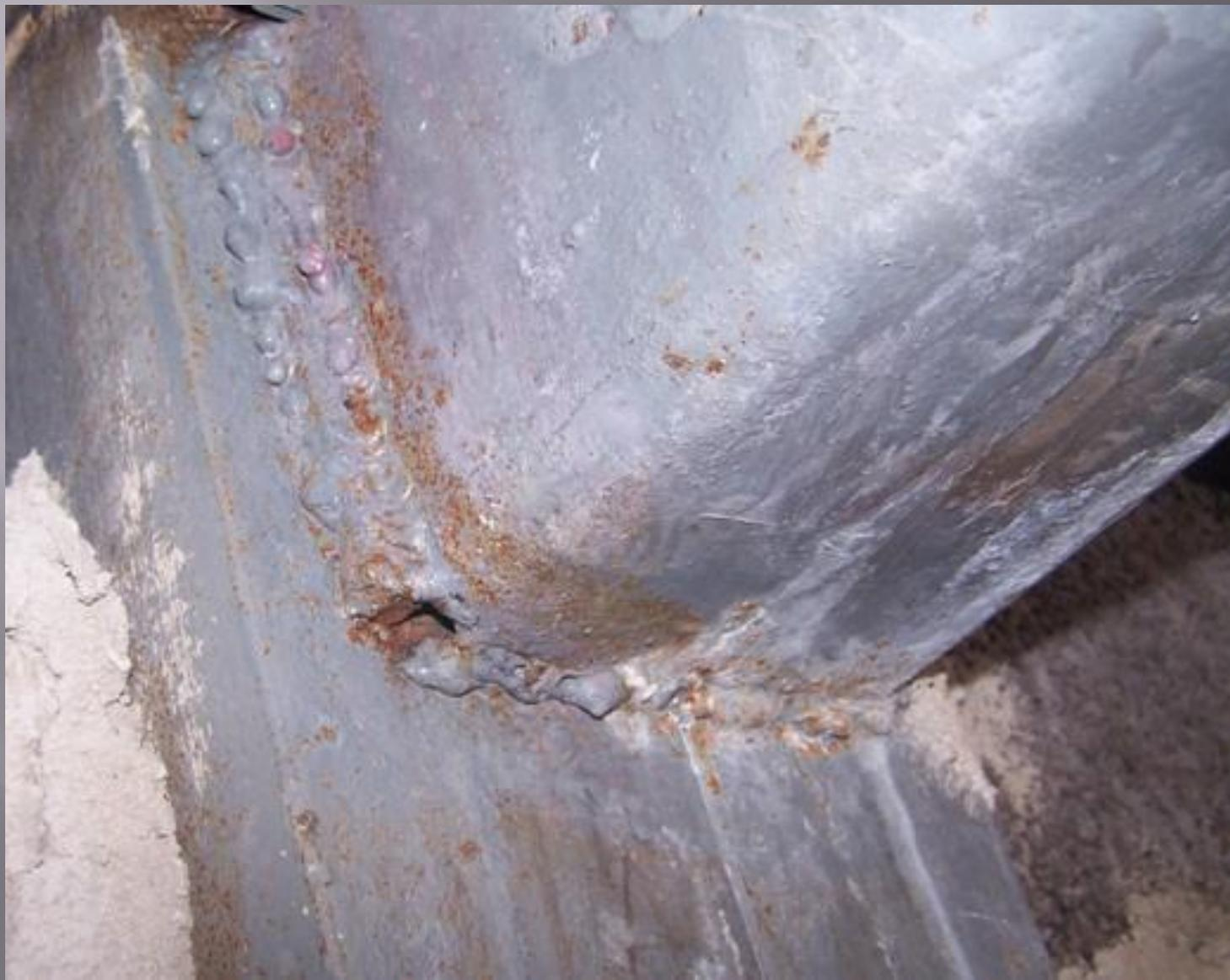
*Непровар сварного шва стойки
