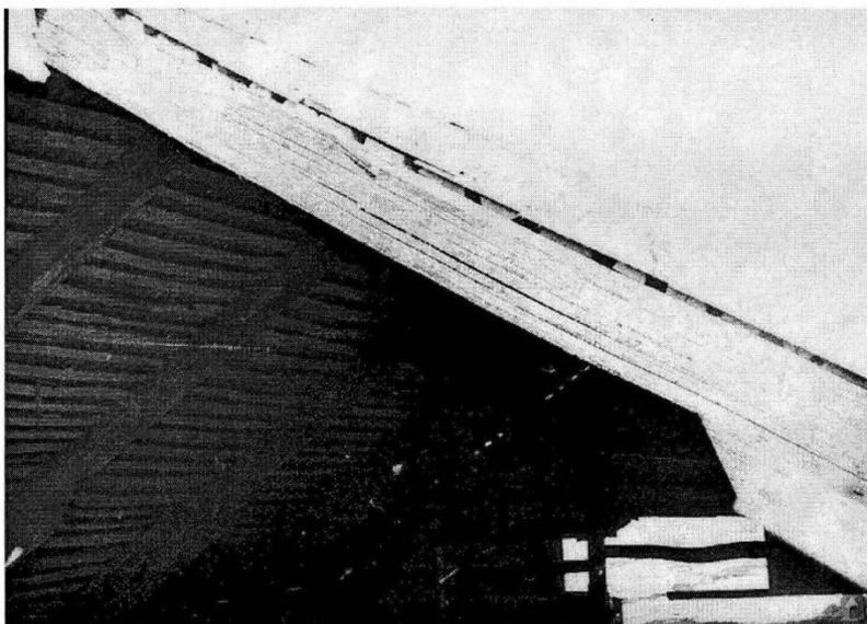
Рисунок 13. Расслоение по клеевым швам и прогиб ригеля гнутоклееной рамы от воздействия односторонней сверхнормативной снеговой нагрузки
