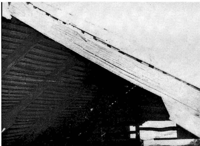
Рисунок 13. Расслоение по клеевым швам и прогиб ригеля гнутоклееной рамы от воздействия односторонней сверхнормативной снеговой нагрузки
