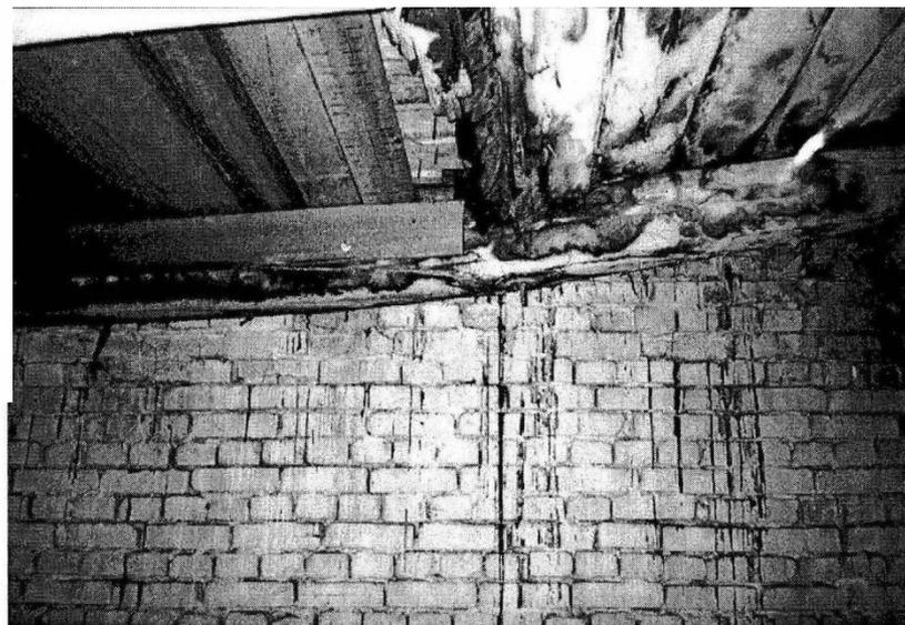
Рисунок 3. Загнивание и излом деревянных конструкций у торцовых стен зданий (из-за постоянного увлажнения атмосферными осадками ввиду разрыва кровли у примыкания к парапету):
