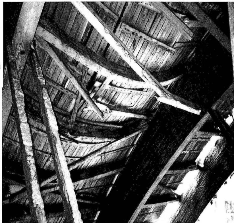
Рисунок 14. Прогиб прогонов покрытия в зоне сверхнормативного отложения снега превышает предельно допустимый прогиб в 2...3 раза
