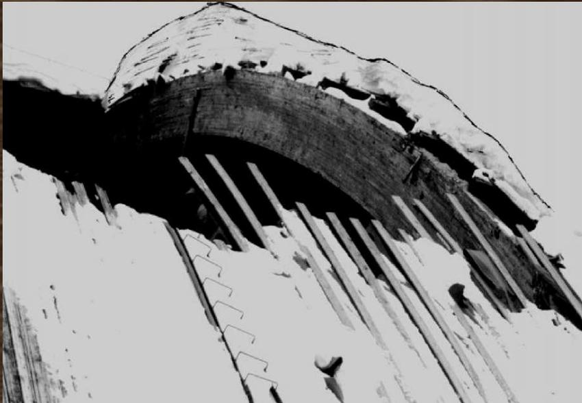
**Сверхнормативная снеговая нагрузка на покрытии из стрельчатых арок пролетом 45 м в момент аварии (максимальная высота снежного покрова 2,6 м)**
