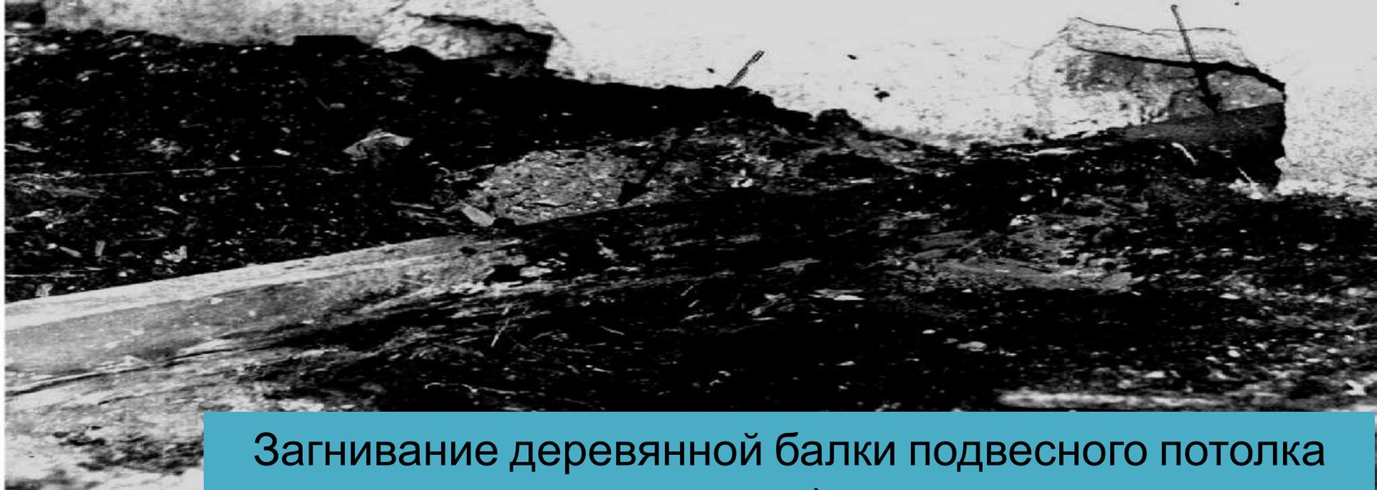
Загнивание деревянной балки подвесного потолка из-за протечек в кровле: а) вид сверху со стороны чердачного помещения б) вид снизу
