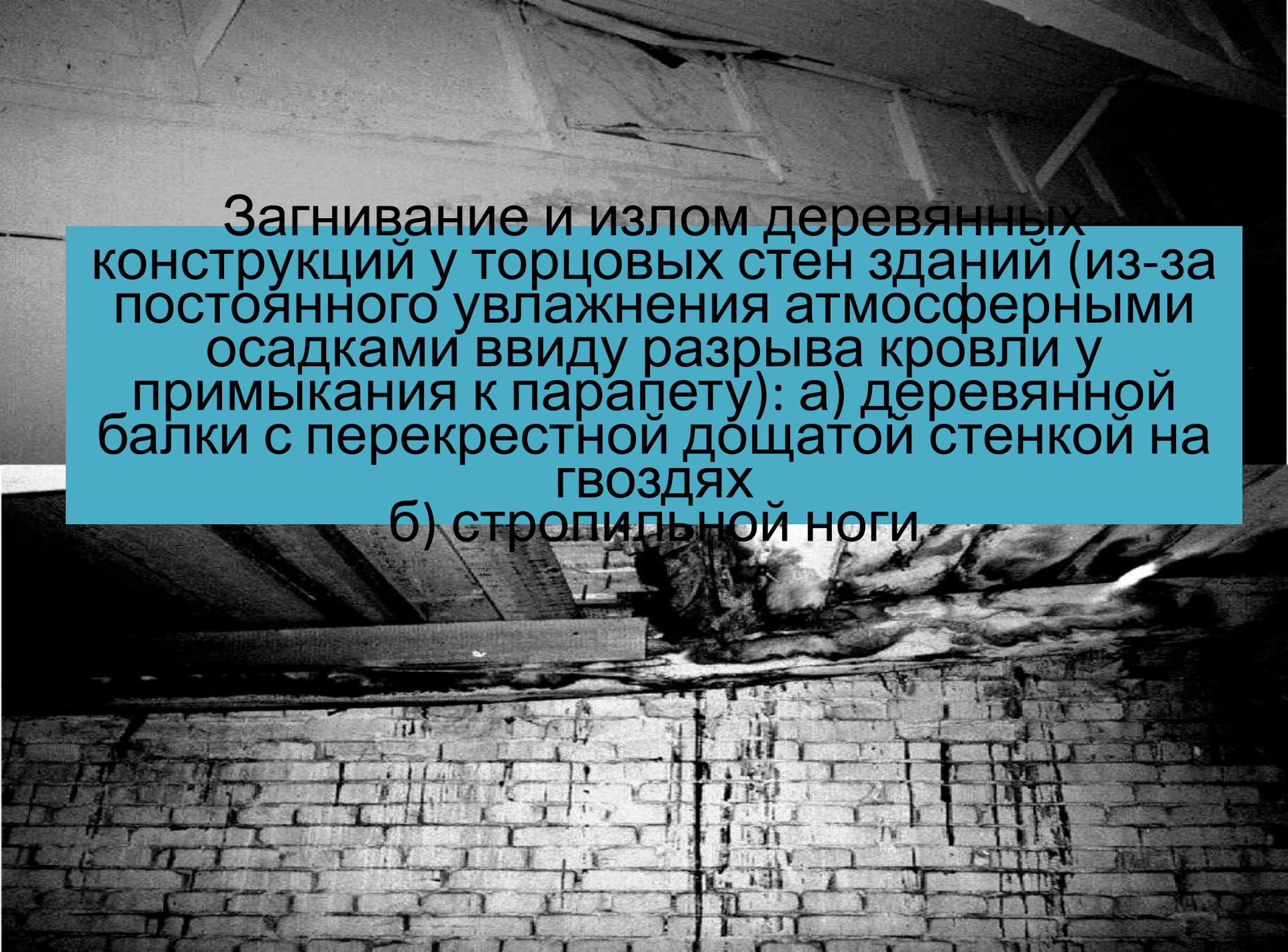
Загнивание и излом деревянных конструкций у торцовых стен зданий (из-за постоянного увлажнения атмосферными осадками ввиду разрыва кровли у примыкания к парапету): а) деревянной балки с перекрестной дощатой стенкой на гвоздях
