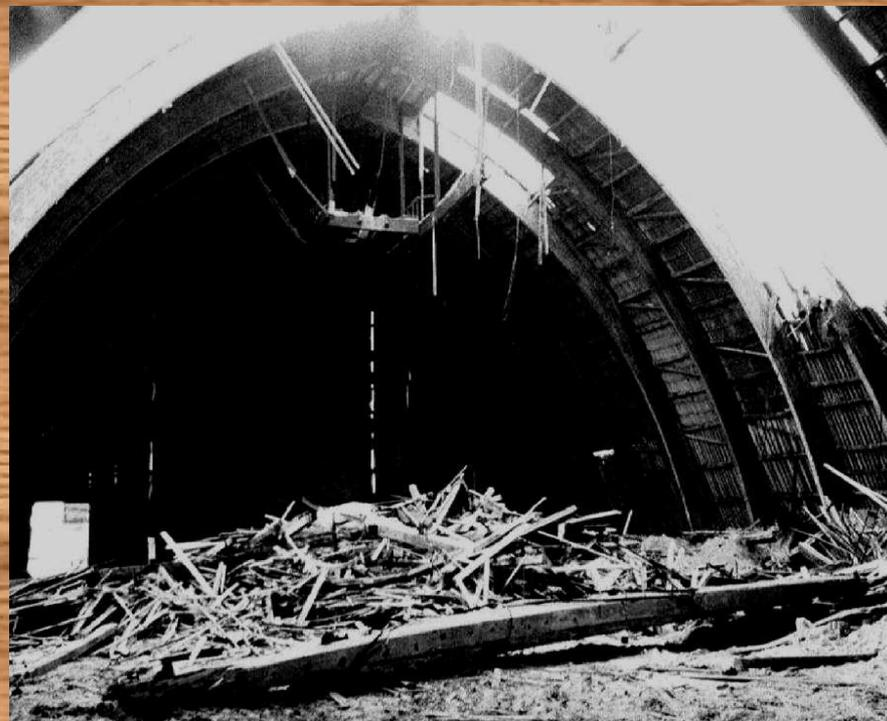
**Общий вид складов из клееных деревянных конструкций после аварии из-за сверхнормативной односторонней снеговой нагрузки а) склад минеральных удобрений из стрельчатых арок б) склад готовой продукции из гнуклееных рам**
