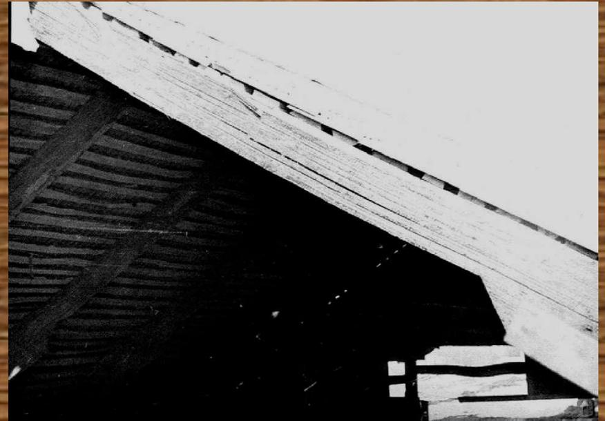
**Прогиб прогонов покрытия в зоне сверхнормативного отложения снега превышает предельно допустимый прогиб в 2...3 раза**
