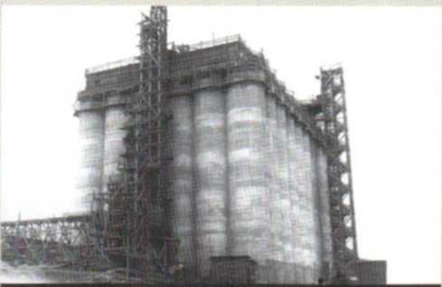
Загальний вигляд будівництва великого елеватора. Херсон. 1932-1933 рр.
