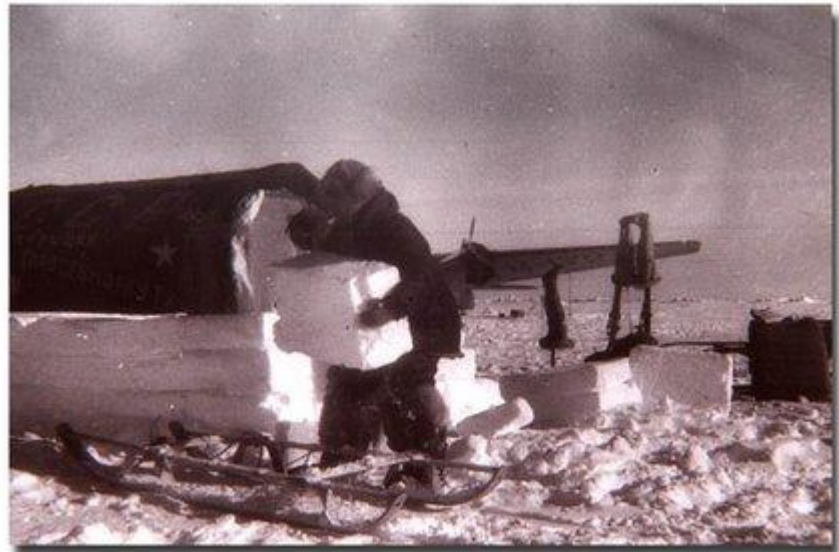
Строительство снежного домика
