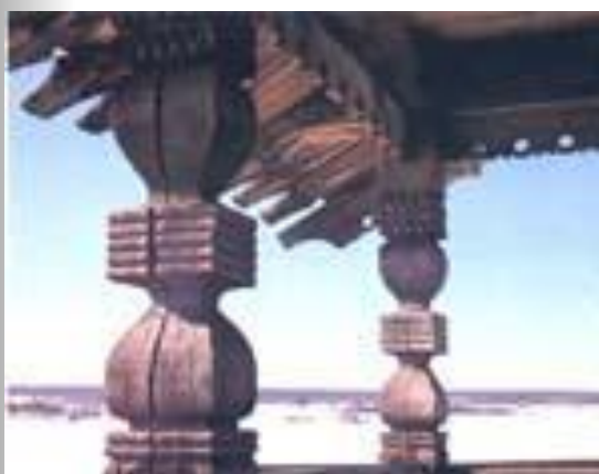
Покровская церковь. Резные столбы крыльца.
