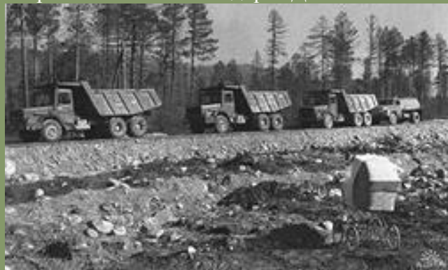
Строителям железных дорог Дальнего Востока
