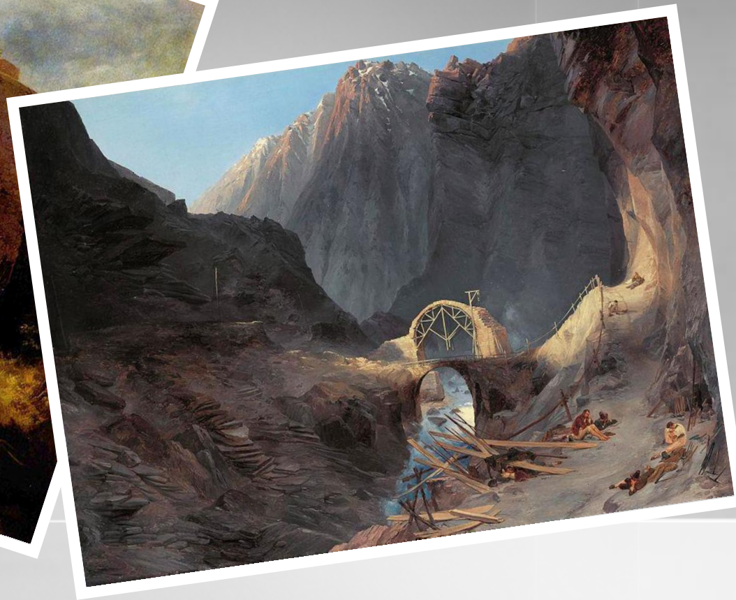
Постройка Чёртова моста, 1830-32
