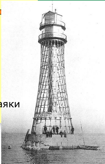
Сетчатые гиперболоидные башни различного назначения
