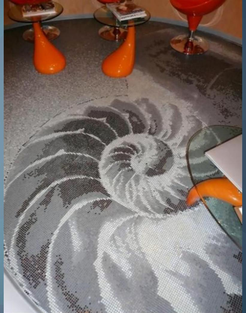
**Стекло мозаичные плитки**, размером например, 21 x 21 x 5 мм – получают при прокате или прессовании стекломассы с разнообразными эстетическими характеристиками, что позволяет создавать оригинальную отделку интерьеров.
