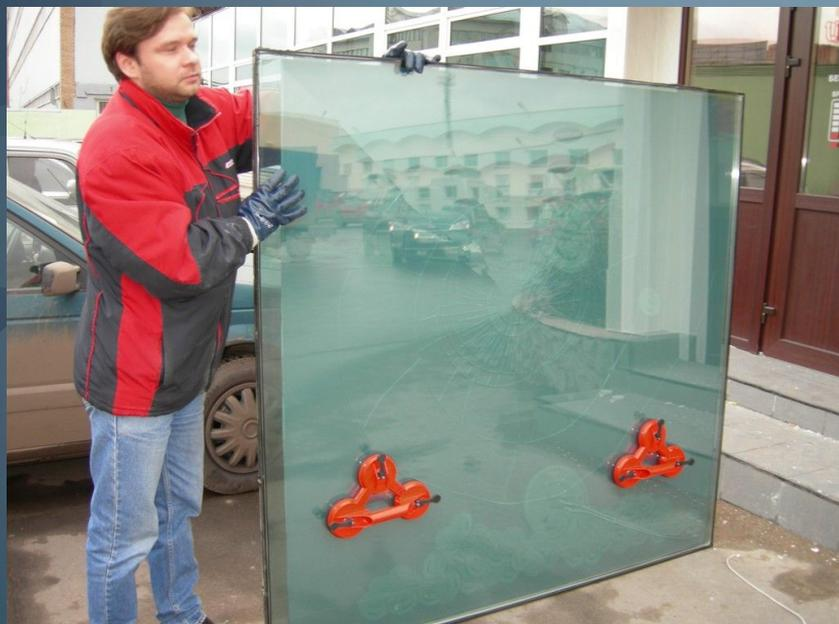
**Витринное стекло** представляет собой крупногабаритные бесцветные листы, как правило, полированные. Один из наименьших размеров 1700 x 1250 мм, наибольших – 3500 x 6000 мм при толщине 5,5...10 мм. Отклонения от размеров полированного стекла по длине и ширине не должны превышать 3 мм, по толщине 0,5 и 0,4 мм (для стекла высшей категории качества).
