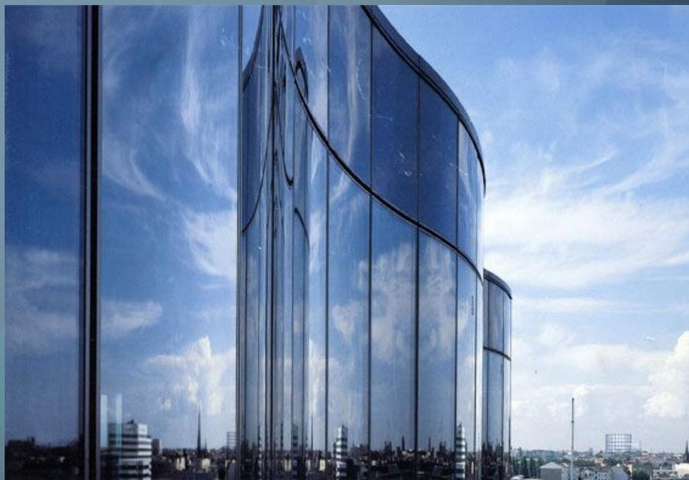
**Изделия в виде гнутых элементов** толщиной от 6 до 39 мм придают своеобразие и оригинальность зданиям многих стран мира. При использовании таких изделий возможны цилиндрическая, коническая, сферическая и другие формы покрытий.
