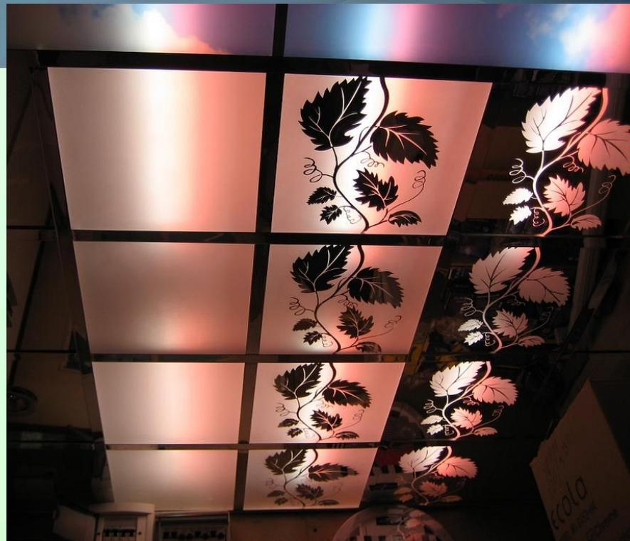
**Матово-узорчатое стекло** изготавливают аналогичной обработкой одной поверхности по трафарету с определенным рисунком. Если на поверхности матированного стекла нанести слой столярного клея и подвергнуть его термообработке, то после снятия клея образуется матово-узорчатое стекло «мороз», имитирующее рисунок замерзшего стекла. К матово-узорчатым стеклам относится и стекло «метелица» с оригинальным рельефным рисунком из произвольно чередующихся участков с матовой и обычной поверхностью.
