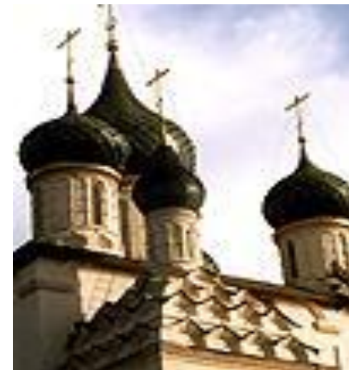
церковь Ильи Пророка в Ярославле.
