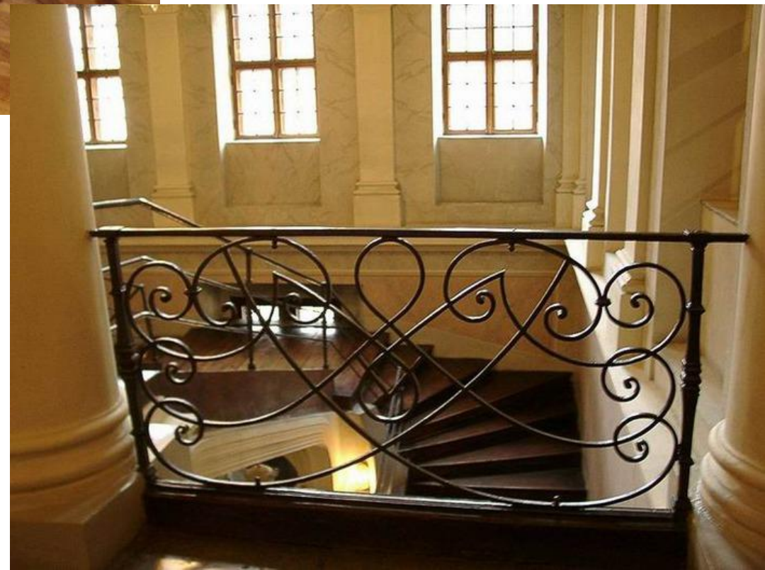
Перила главной лестницы.
