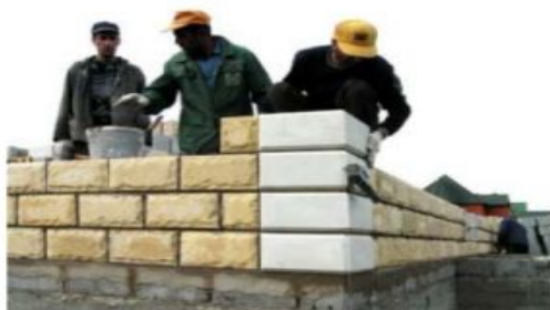
Обычная кладка стен
