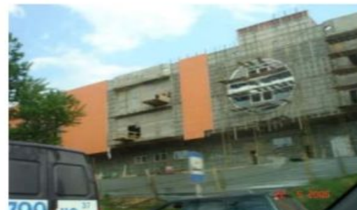
Установка навесного фасада
