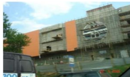
Установка навесного фасада
