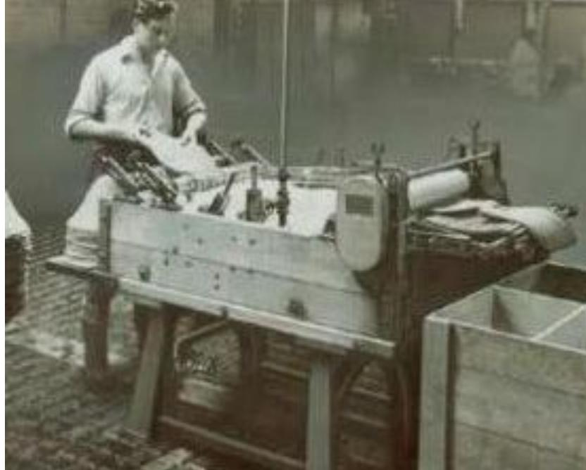
В середине 19, начале 20 веков изобрели валяльные прессы, и валяльные машины. Валка происходила посредством сдавливания и прокатывания шерсти или при механическом воздействии специальных иголок, которые спутывали шерстяные волокна
