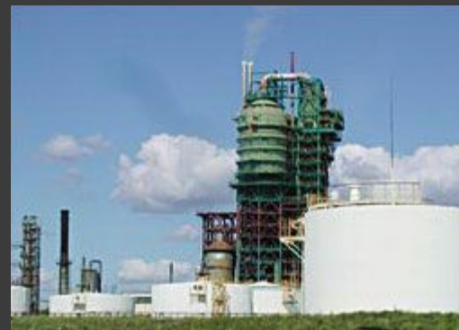
Установка каталитического крекинга на Ярославнефтеоргсинтезе, пущена в 2000 году после коренной реконструкции. Аппарат большого диаметра на этажерке - регенератор.
