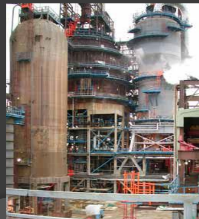
Реакторный блок каталитического крекинга по технологии ExxonMobil. В правой части - реактор, слева от него - регенератор.
