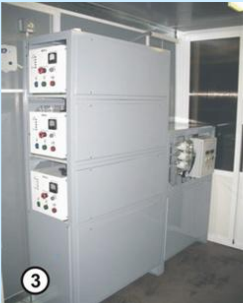
ОЗОНАТОР С СИСТЕМОЙ ОХЛАЖДЕНИЯ
