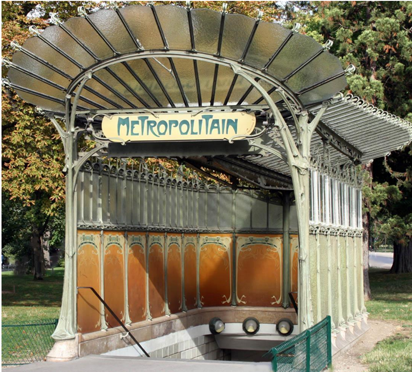
Вход в метро Porte Dauphine. Париж. 1899-1900
