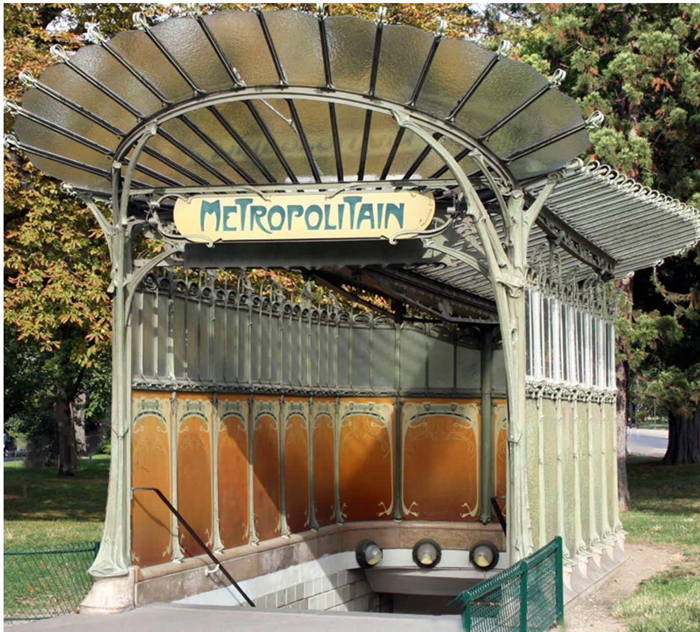
Вход в метро Porte Dauphine. Париж. 1899-1900
