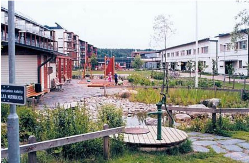
Для обеспечения поступления тепла солнечной радиации в зимний месяцы все здания длинными фасадами ориентированы на южную и юго-западную сторону. Здания расположены таким образом, что дворы освещаются до вечера.
