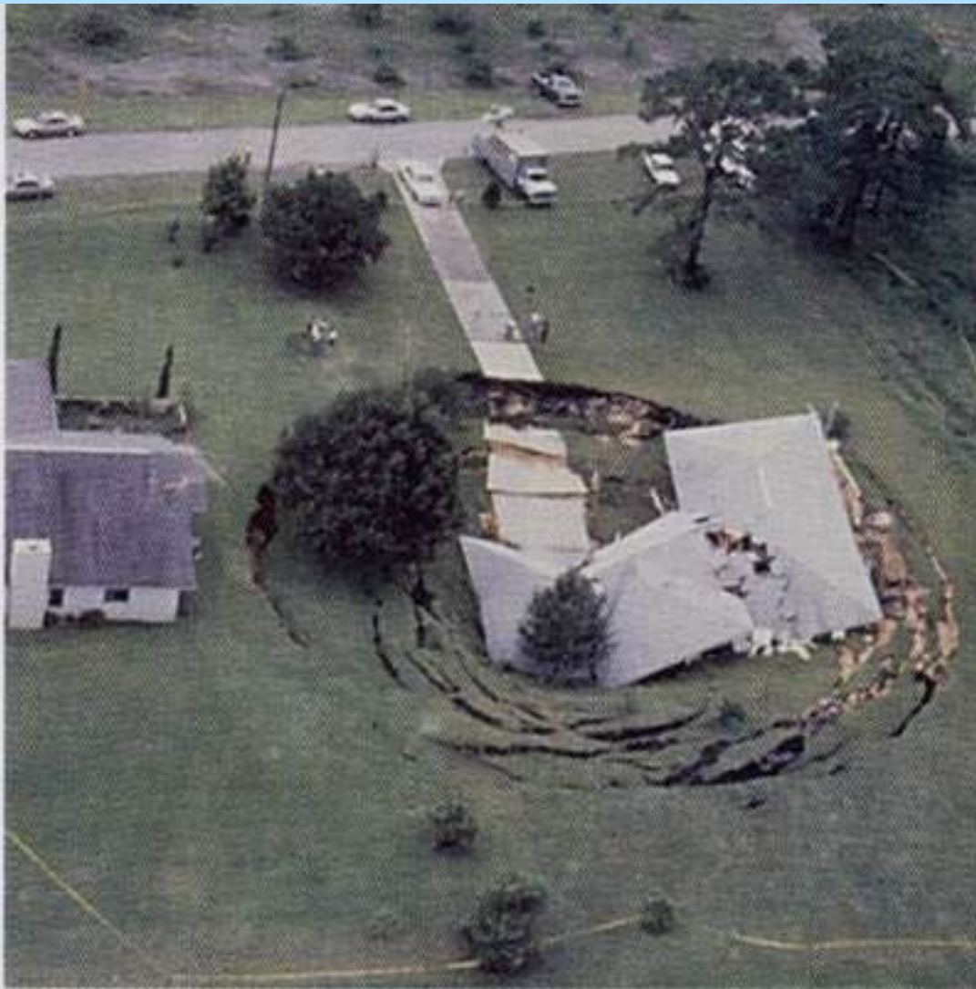
Провальная карстово-суффозионная воронка под жилым зданием
