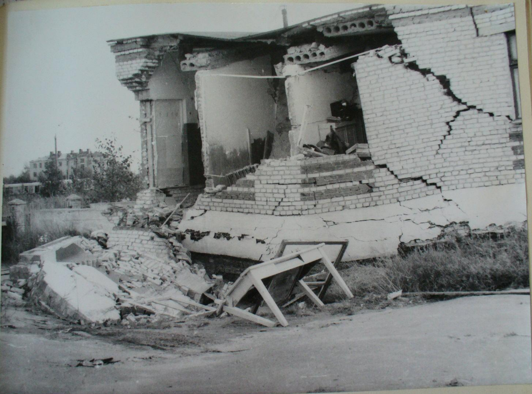
Провал у здания ветлечебницы г.Дзержинска (10.09.70г.Диаметр 12,5м)
