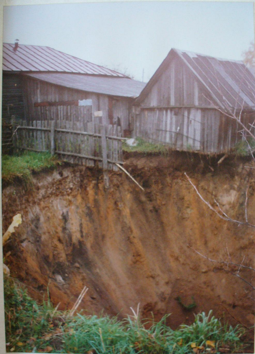
Провал в селе Чудь Навашинского района (30.09.95г. диаметр 14,4-16,5 м, гл. 11,5 м)
