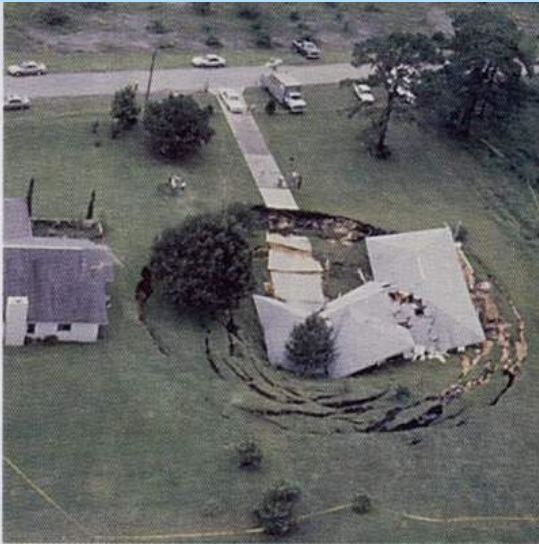
Провальная карстovo-суффозионная воронка под жилым зданием
