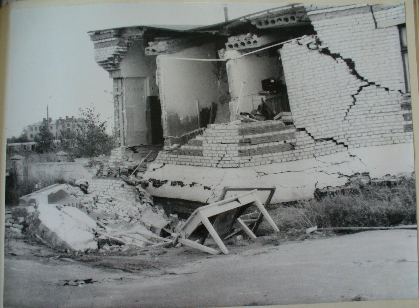
Провал у здания ветлечебницы г.Дзержинска (10.09.70г.Диаметр 12,5м)
