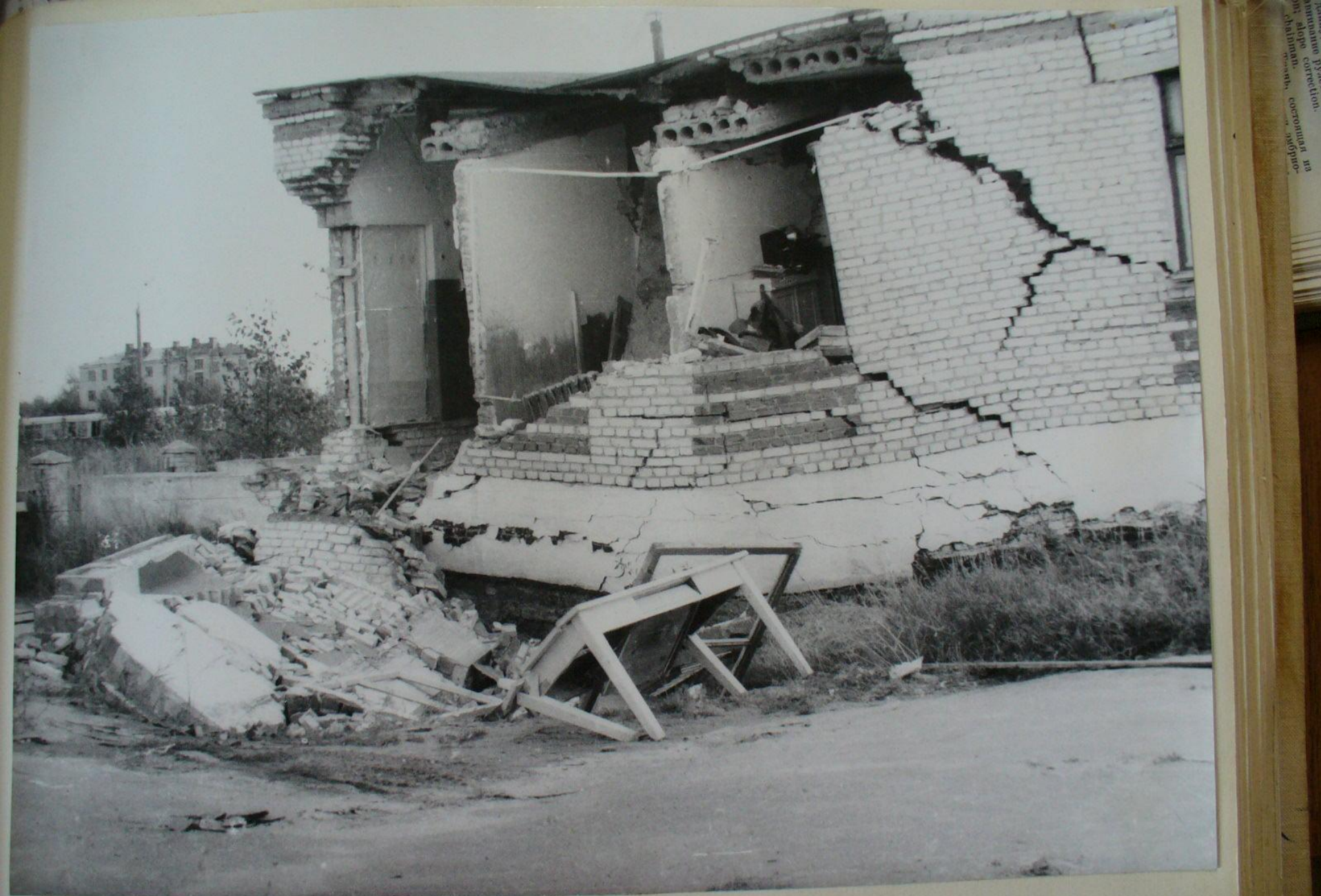
Провал у здания ветлечебницы г.Дзержинска (10.09.70г.Диаметр 12,5м)
