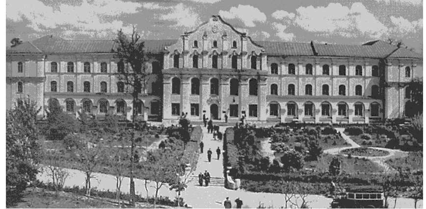
Вид на корпус № 1 та сквер з корпусу № 2. Фото 1951р.
