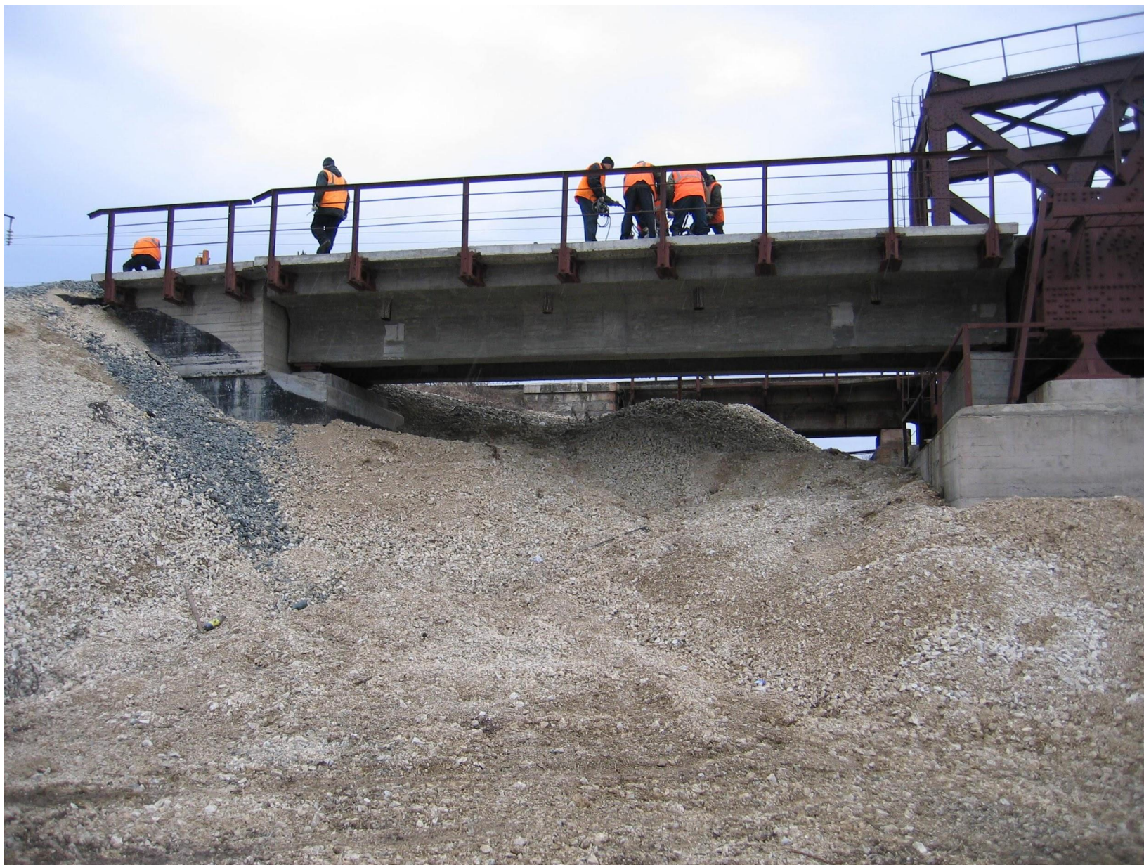
Мост через р. Кудьма на 323 км линии Арзамас – Горький 6-й (Горький - Казанский) дистанции пути. Горьковская ж.д.
