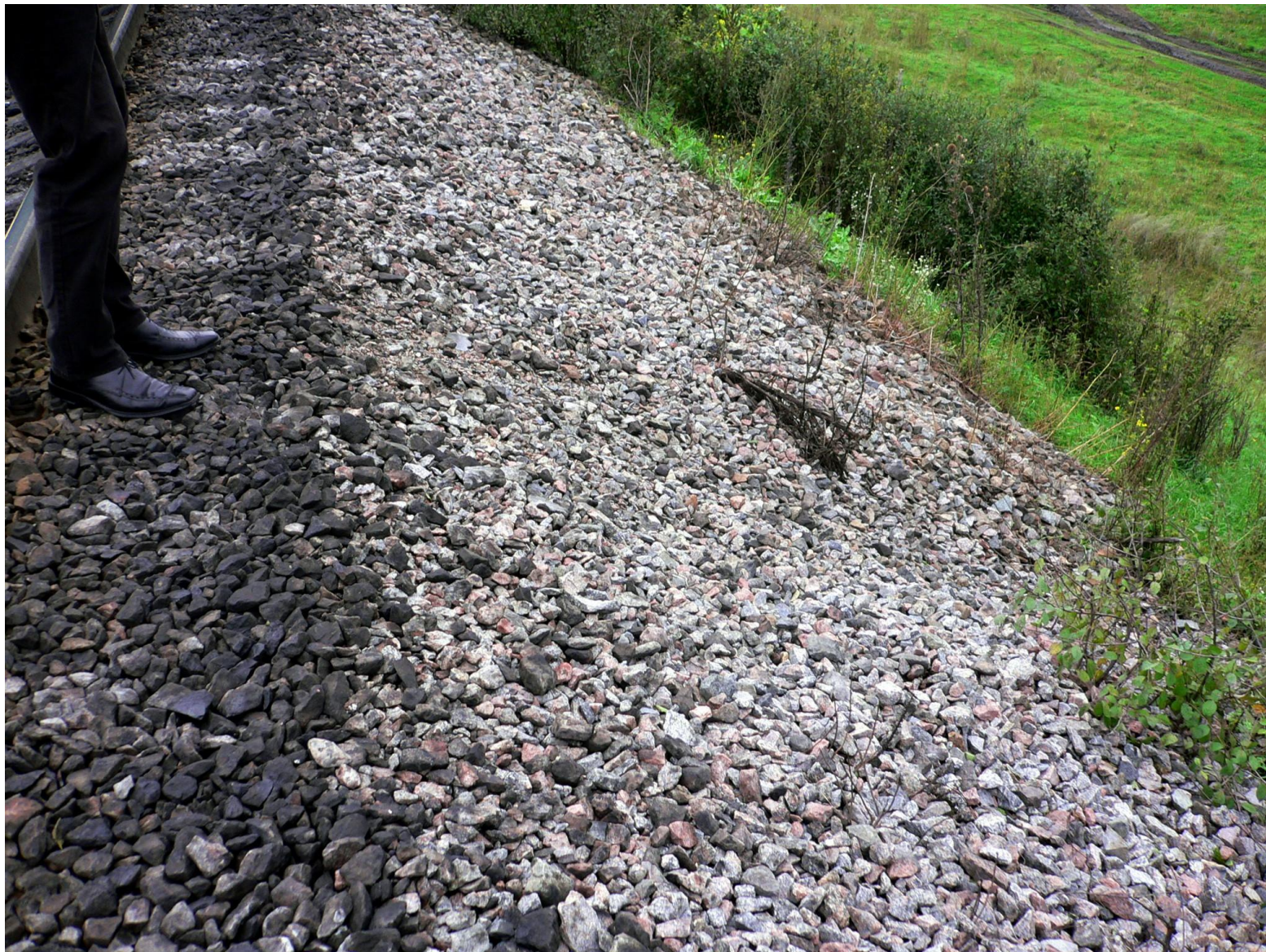
Типичный вид «обочины» после капитального ремонта пути и сдача его в эксплуатацию.
