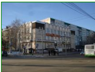
Торгово-офисное здание, г. Тюмень
