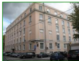
Офисный центр на ул. Александра Солженицына, д.27, г.Москва
