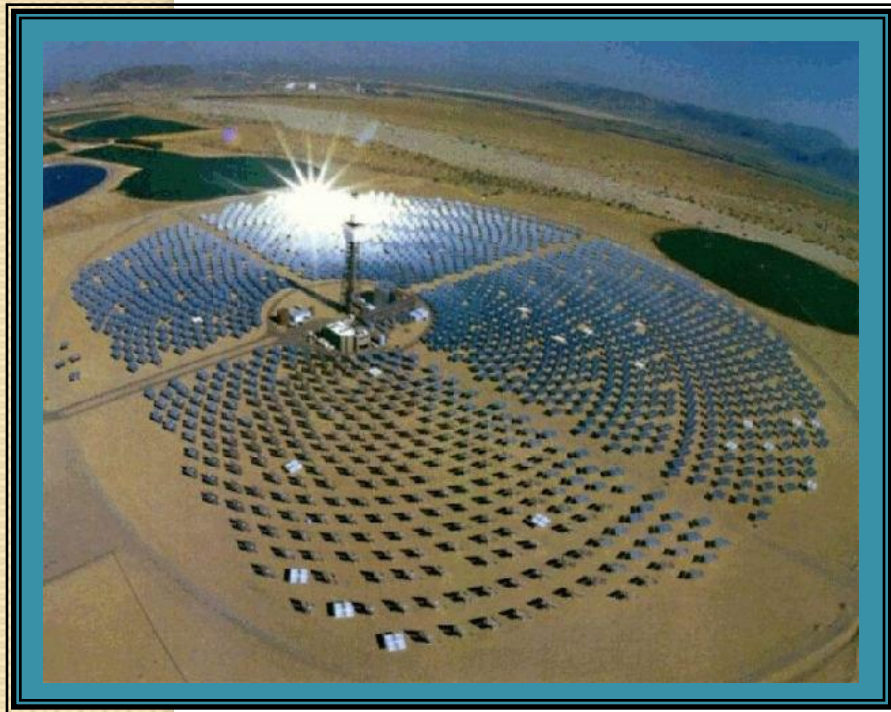
Солнечная электростанция (СЭС)
