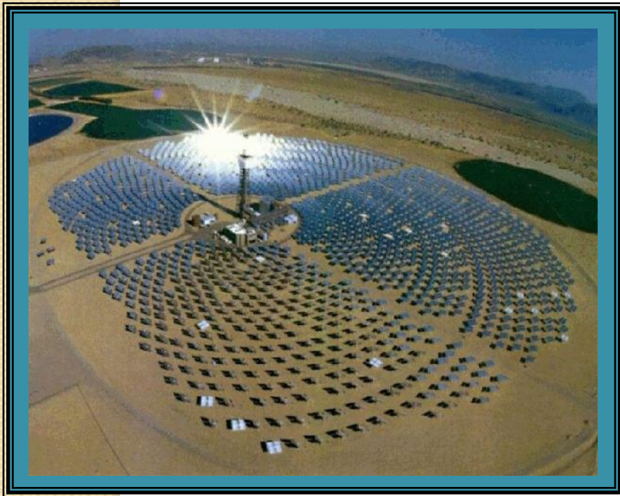
Солнечная электростанция (СЭС)
