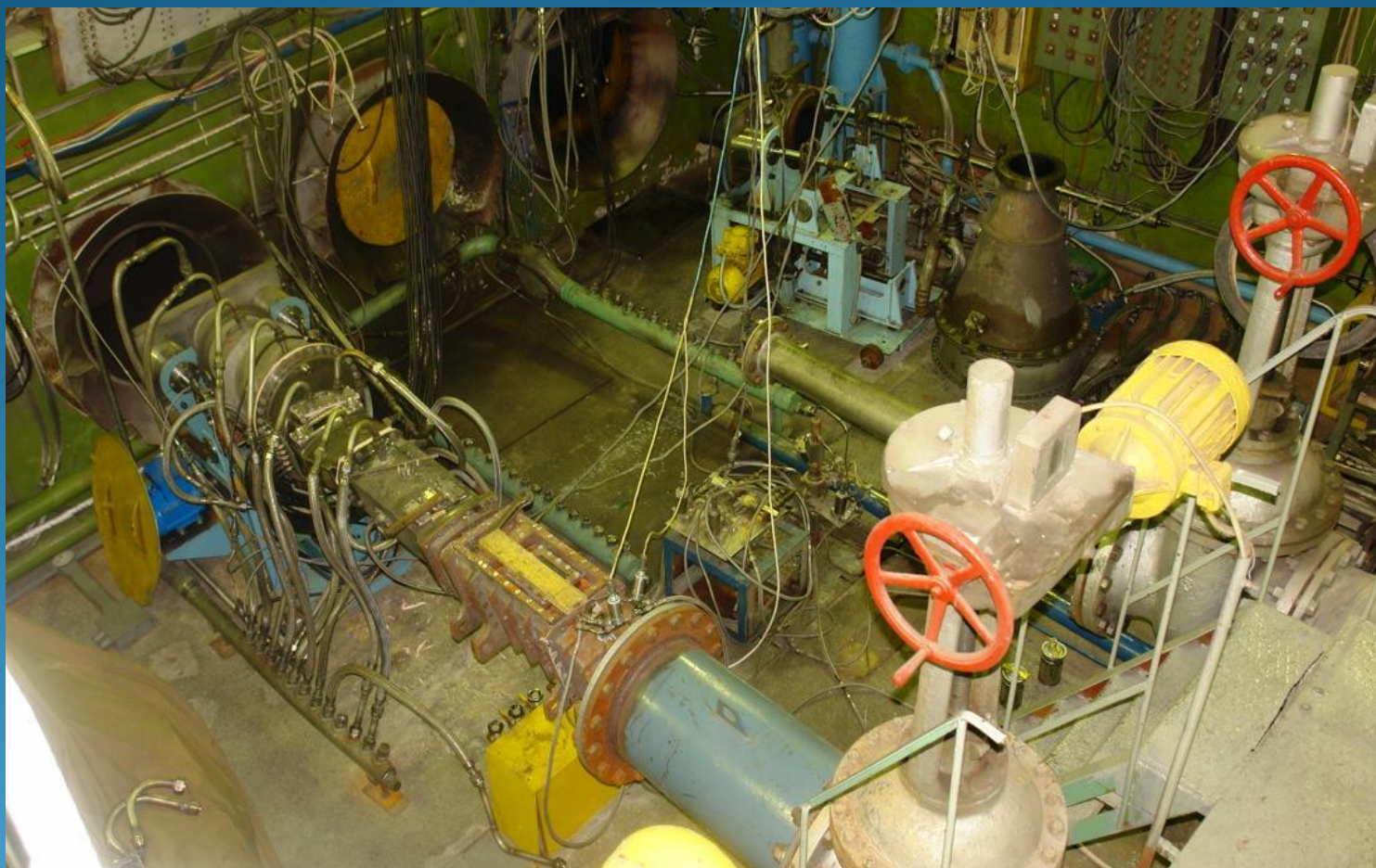
Установка для испытания камер сгорания ГТД
