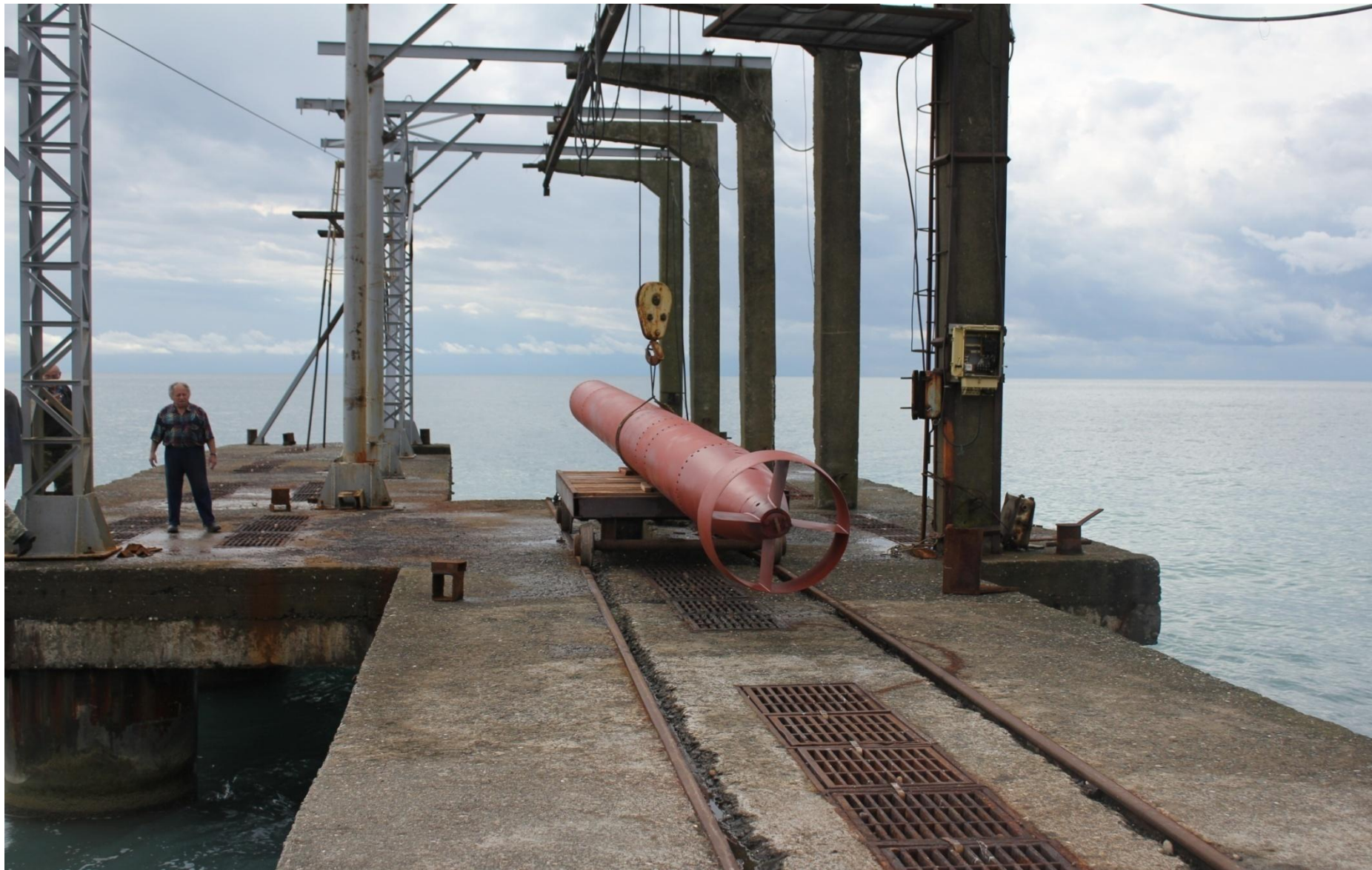
Рис.14. Береговая эстакада – пирс с установленным на нем всплывающим устройством
