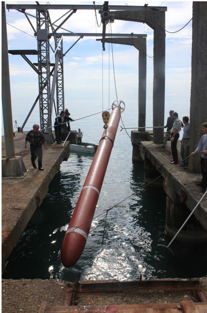
Рис.25. Подъем Всплывающего устройства на берег
