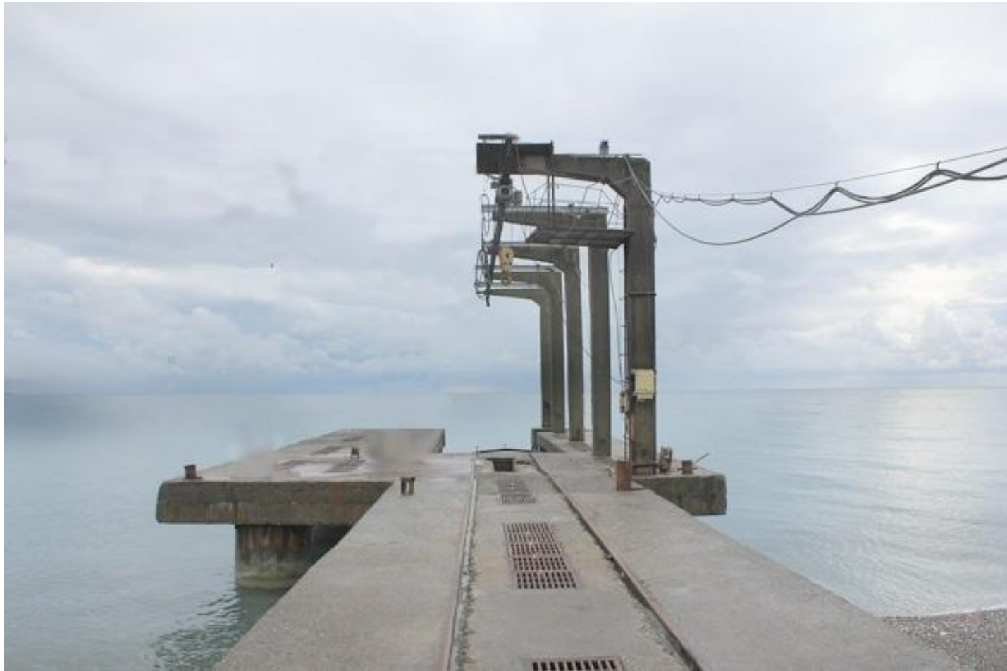
Рис. 8. Береговая эстакада, оборудованная грузоподъёмным средством - тельфером грузоподъёмностью 3 тонны
