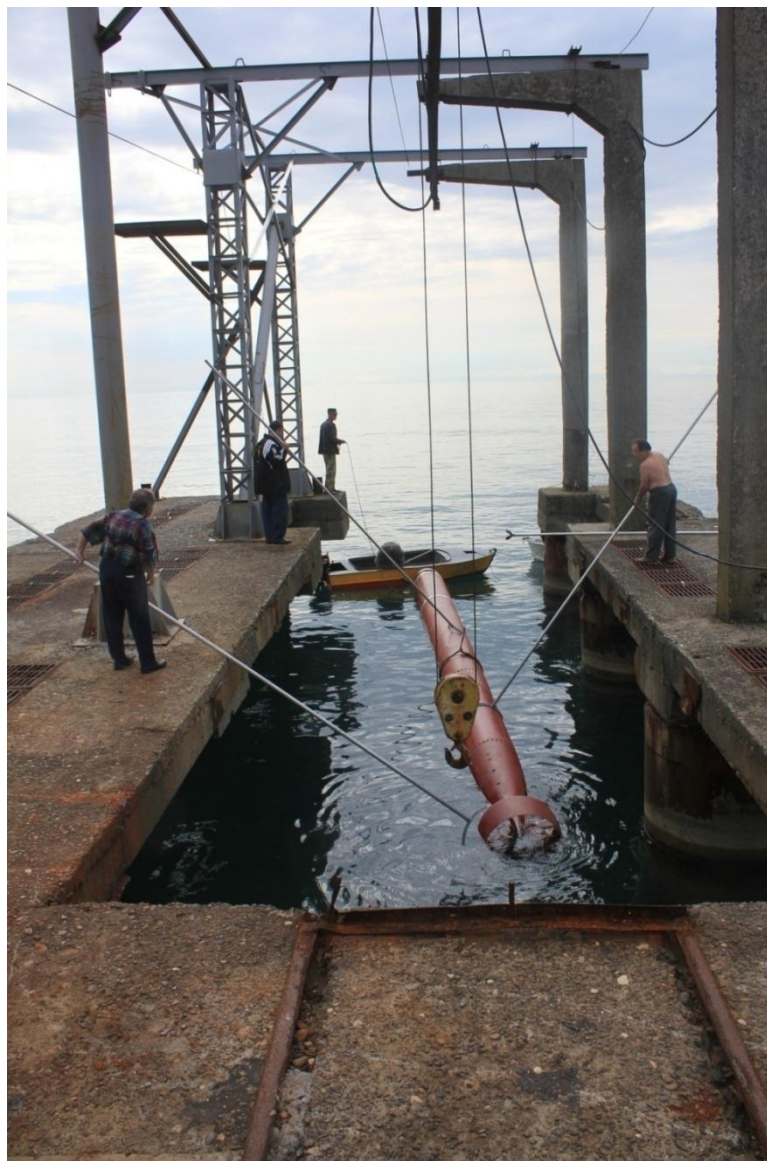
Рис.18.Береговая эстакада: смонтирована опорная конструкция для погружения Всплывающего устройств в море.
