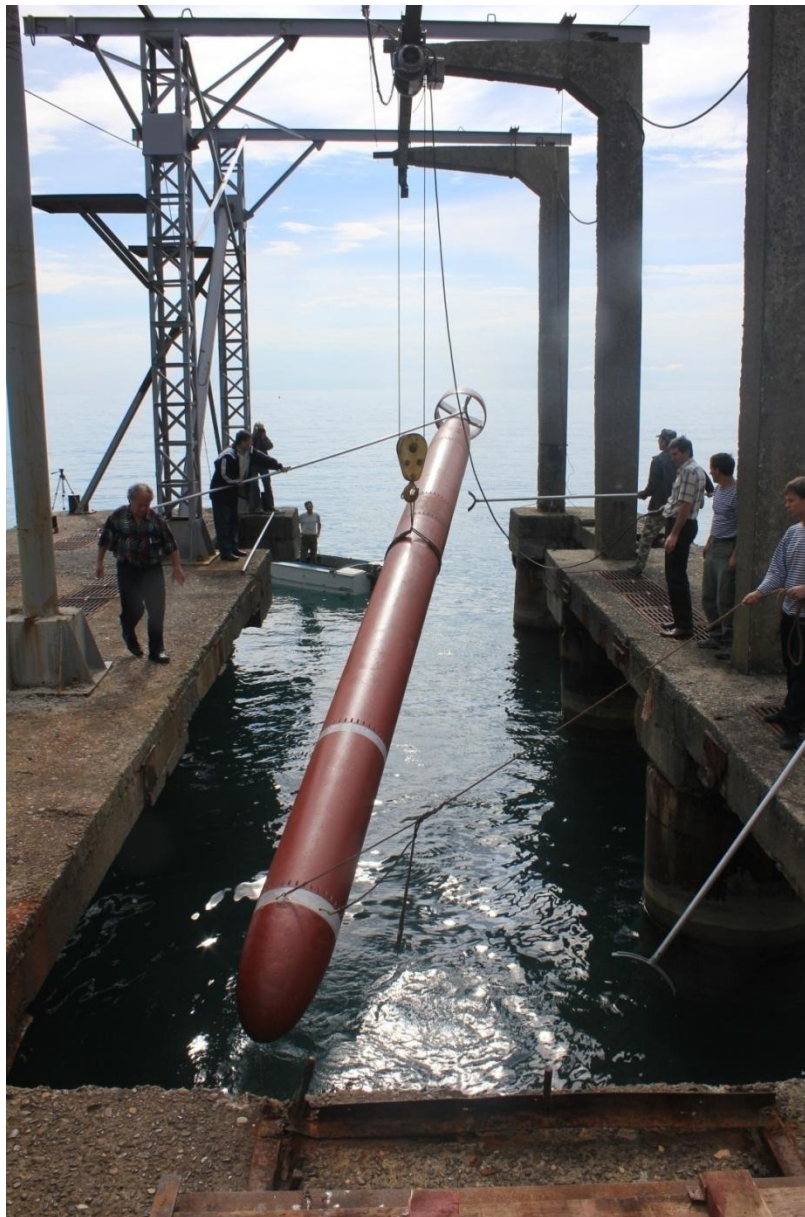
Рис.25. Подъем Всплывающего устройства на берег
