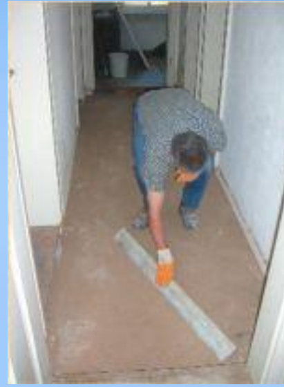
Устройство выравнивающей стяжки
