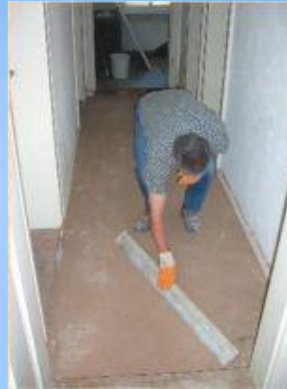
Устройство выравнивающей стяжки
