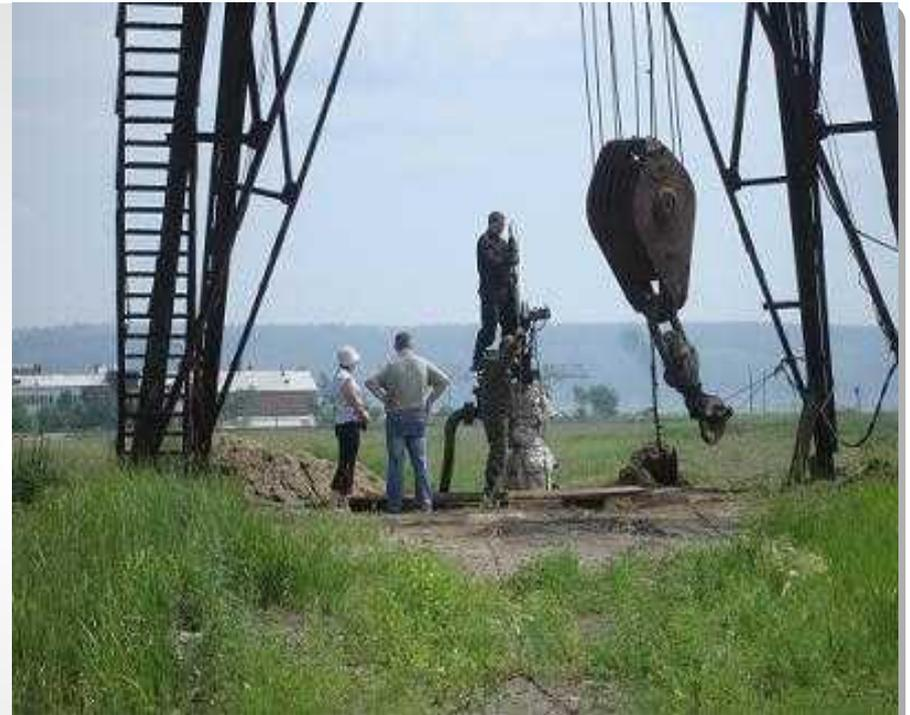
**Исследование скважины через колонну и в открытой камере.
