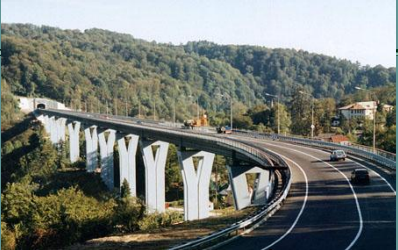
Мост через р. Мацесту в г. Сочи
