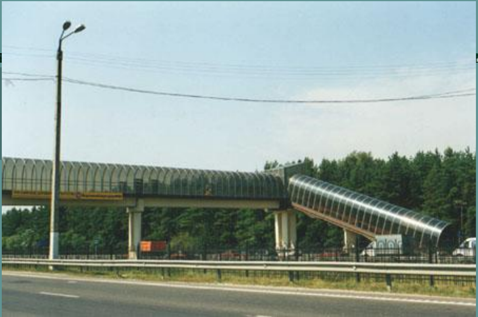
Пешеходный мост на 504 км автодороги
