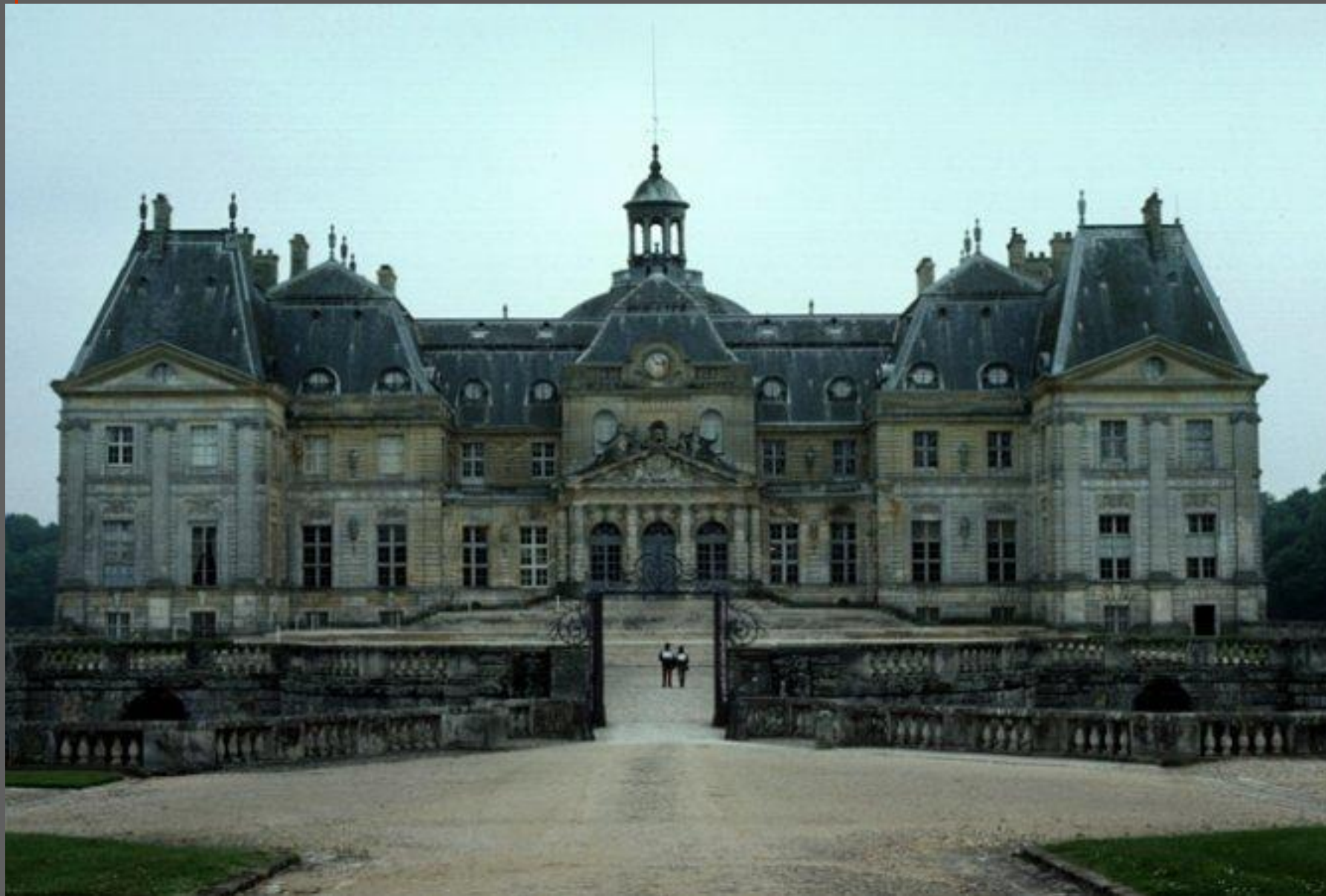
Луи Лево, Андре Ленотр. Во-ле-Виконт 1656—1661. Главный фасад.
