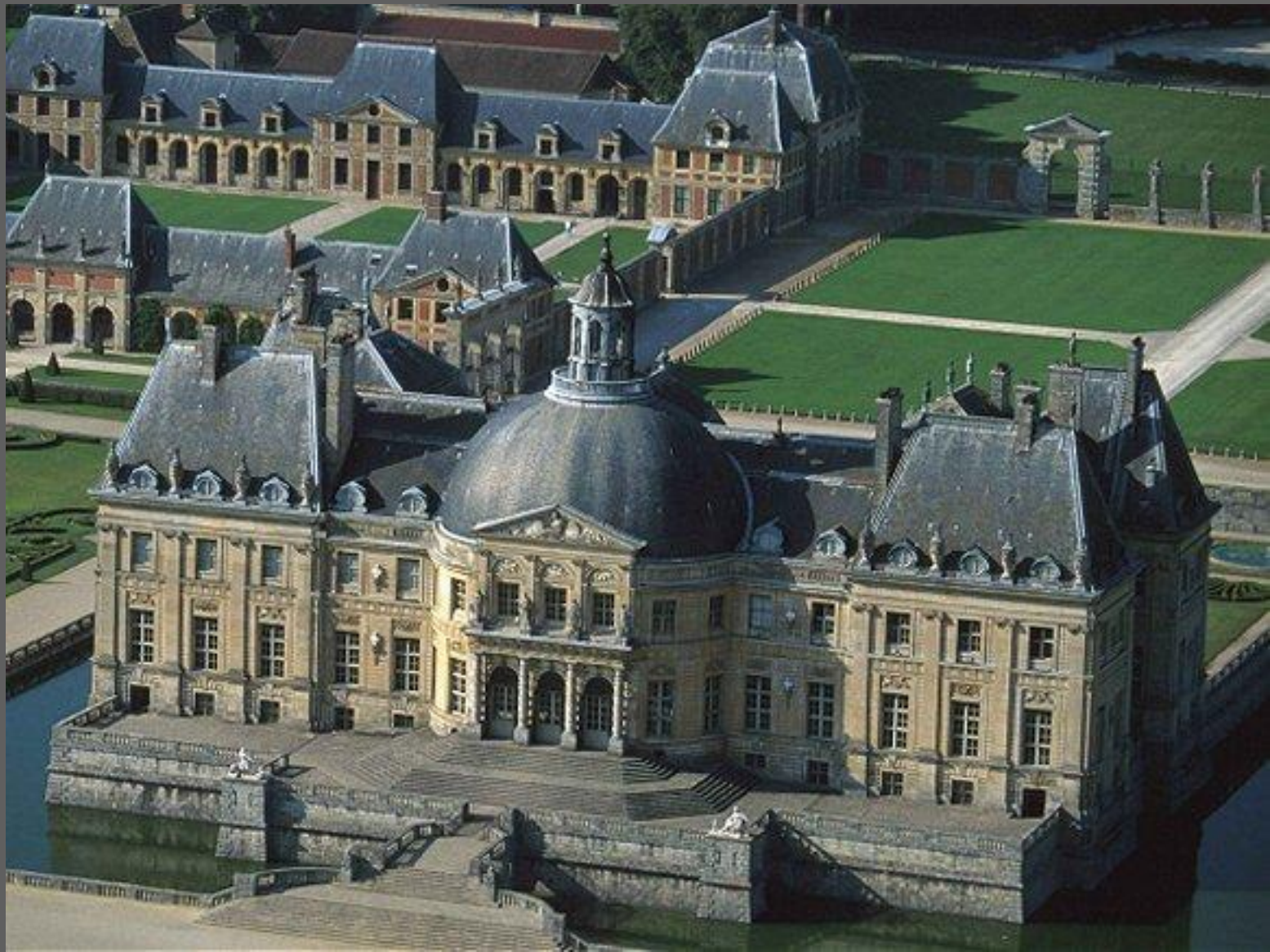
Луи Лево, Андре Ленотр. Во-ле-Виконт 1656—1661. Парковый фасад.
