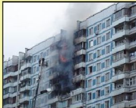
Москва. Первая подъехавшая пожарная машина с лестницей не достала верхние этажи.
