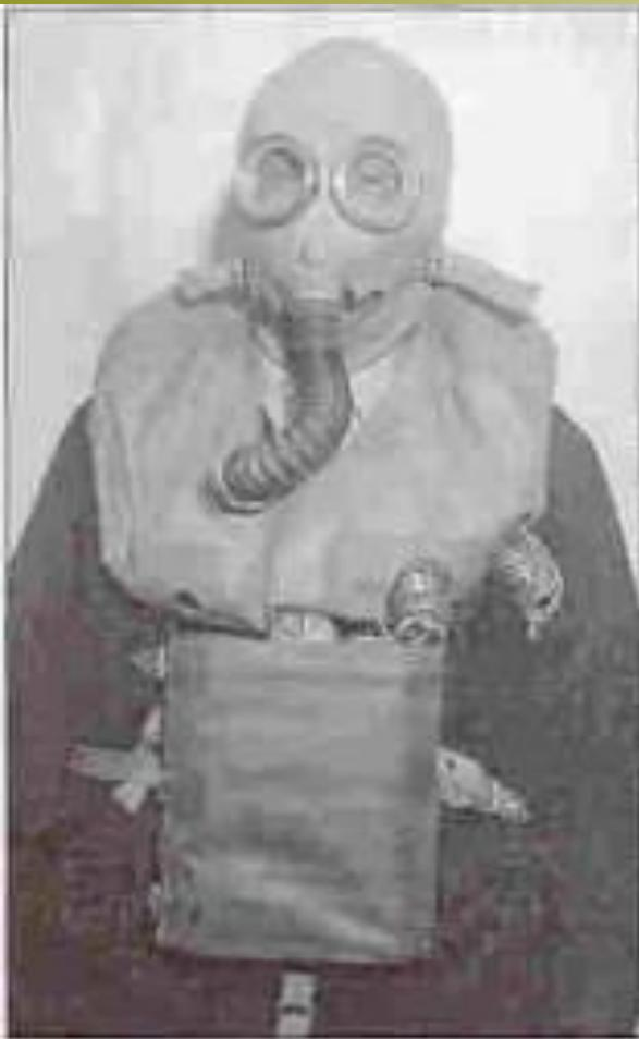
Является индивидуальным аварийно-спасательным средством и предназначен для выхода из затопленных (затонувших) объектов бронетанковой техники методом свободного всплытия со скоростью 1 м/с или методом постепенного подъема на поверхность воды,
