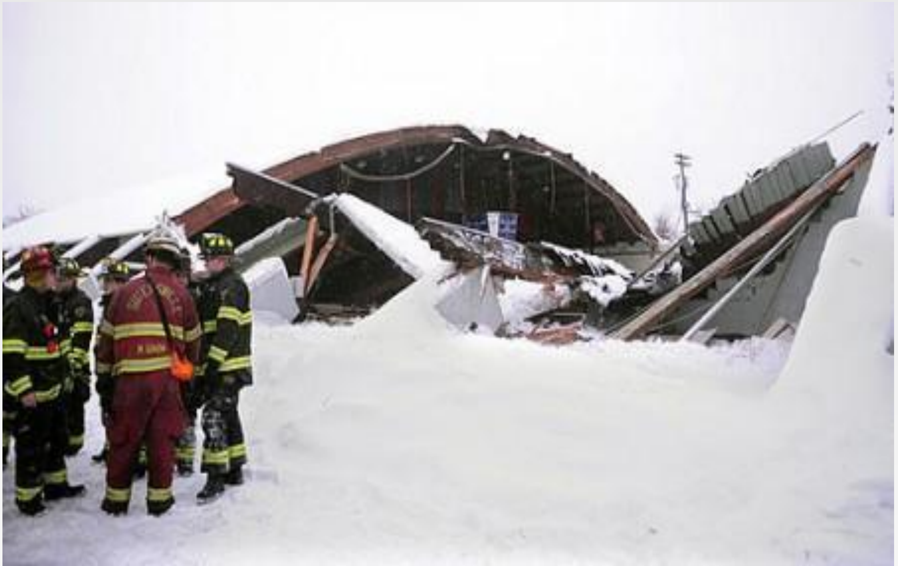
На стадионе американского города Ростравер в штате Пенсильвания во время хоккейного матча произошло частичное обрушение крыши стадиона (5 тыс. зрителей)
