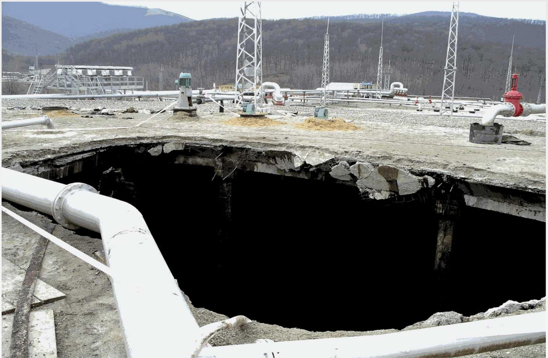
Обрушение крыши железобетонного подземного резервуара №49 емкостью 10000м3 на ПНБ "Грушовая" ОАО "Черномортранснефть"
