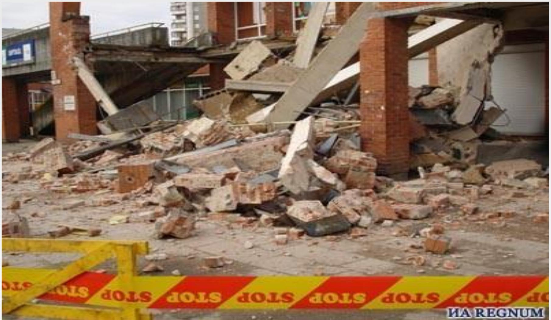
По рассказам местных жителей, власти давно были предупреждены, что здания в аварийном состоянии: бетонные перекрытия в трещинах, а арматура разъедена коррозией
