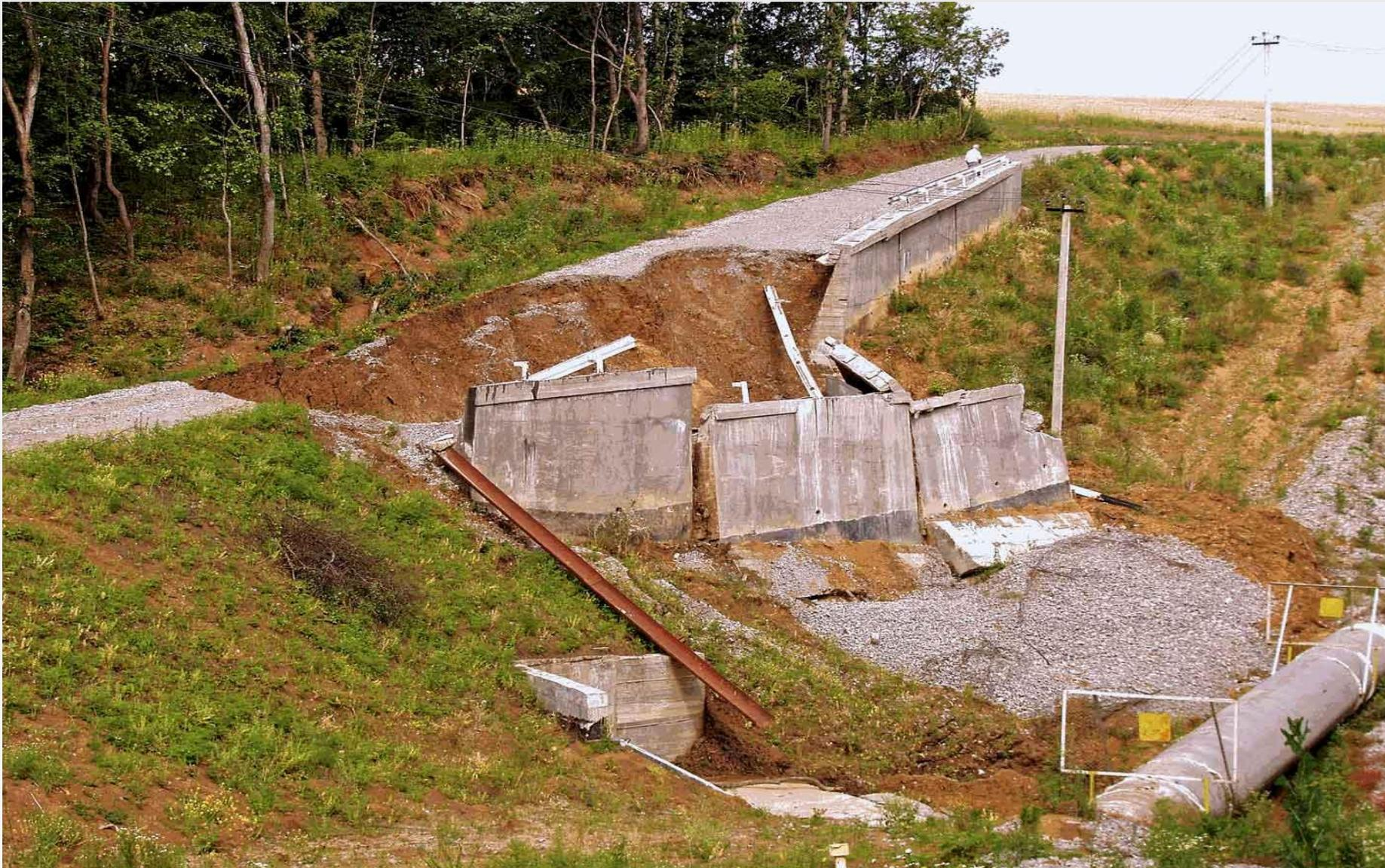
Обрушение подпорной стенки эксплуатационной дороги газопровода "Россия-Турция" (в районе ст.Северской)
