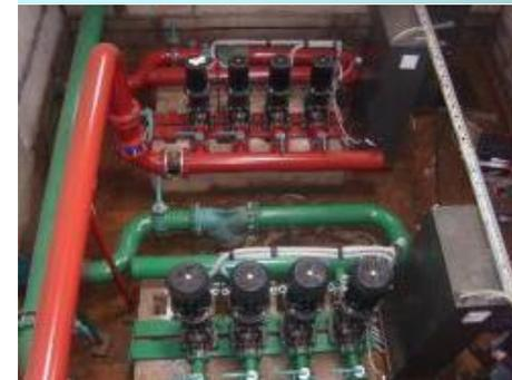
СУН может включать в себя частотные преобразователи, устройства плавного пуска, контроллеры, силовые коммутационные устройства, датчики давления, температуры, устройства защиты от сухого хода. СУН обеспечивает управление насосами по заданному гидравлическому параметру (давлению, расходу, разности давлений, уровню жидкости в емкости)
