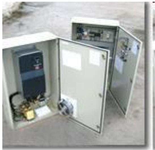
Шкафы ИСТОК для управления насосными агрегатами служат для автоматического регулирования расхода и давления в гидросистеме за счет применения частотного преобразователя и датчика давления
