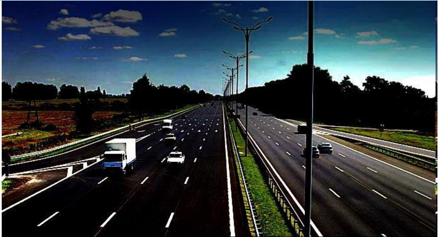
**"Автомагистраль"** - дорога, обозначенная знаком 5.1 и имеющая для каждого направления движения проезжие части, отделенные друг от друга разделительной полосой (а при ее отсутствии - дорожным ограждением), без пересечений в одном уровне с другими дорогами, железнодорожными или трамвайными путями, пешеходными или велосипедными дорожками.
