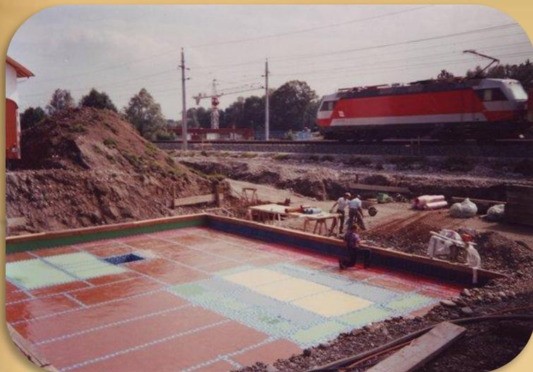
• Применяется в качестве упругого элемента для виброизоляции инженерного оборудования, фундаментов зданий, рельсовых путей, в конструкциях плавающих полов и др. Характеристики виброопор подбираются в соответствии с условиями применения, видом конструкции и методом строительства
