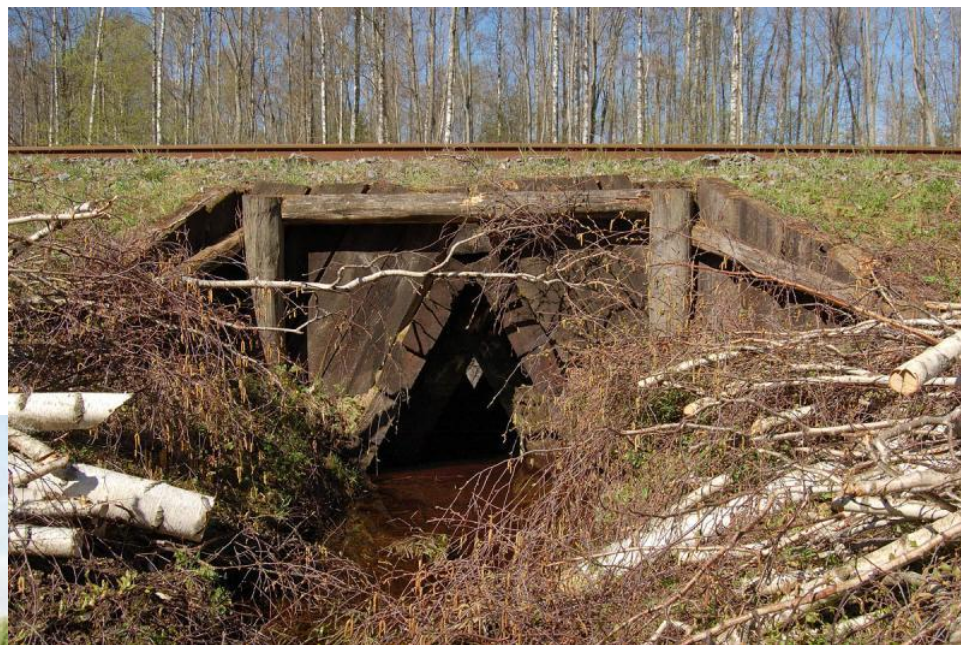
Ручей в деревянной трубе на участке Захонье-Добручи
