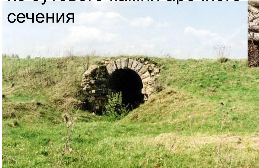
Водопропускная труба на старой насыпи перегона Ожерелье - Пчеловодное
