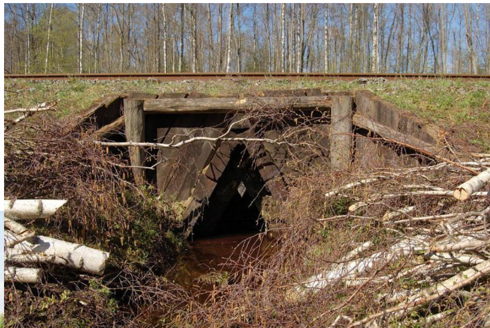
Ручей в деревянной трубе на участке Захонье-Добручи
