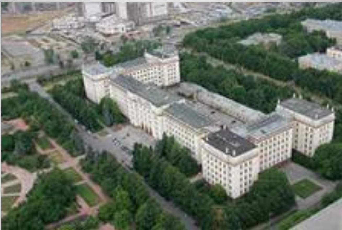
Химический корпус (здание ХФ МГУ)
