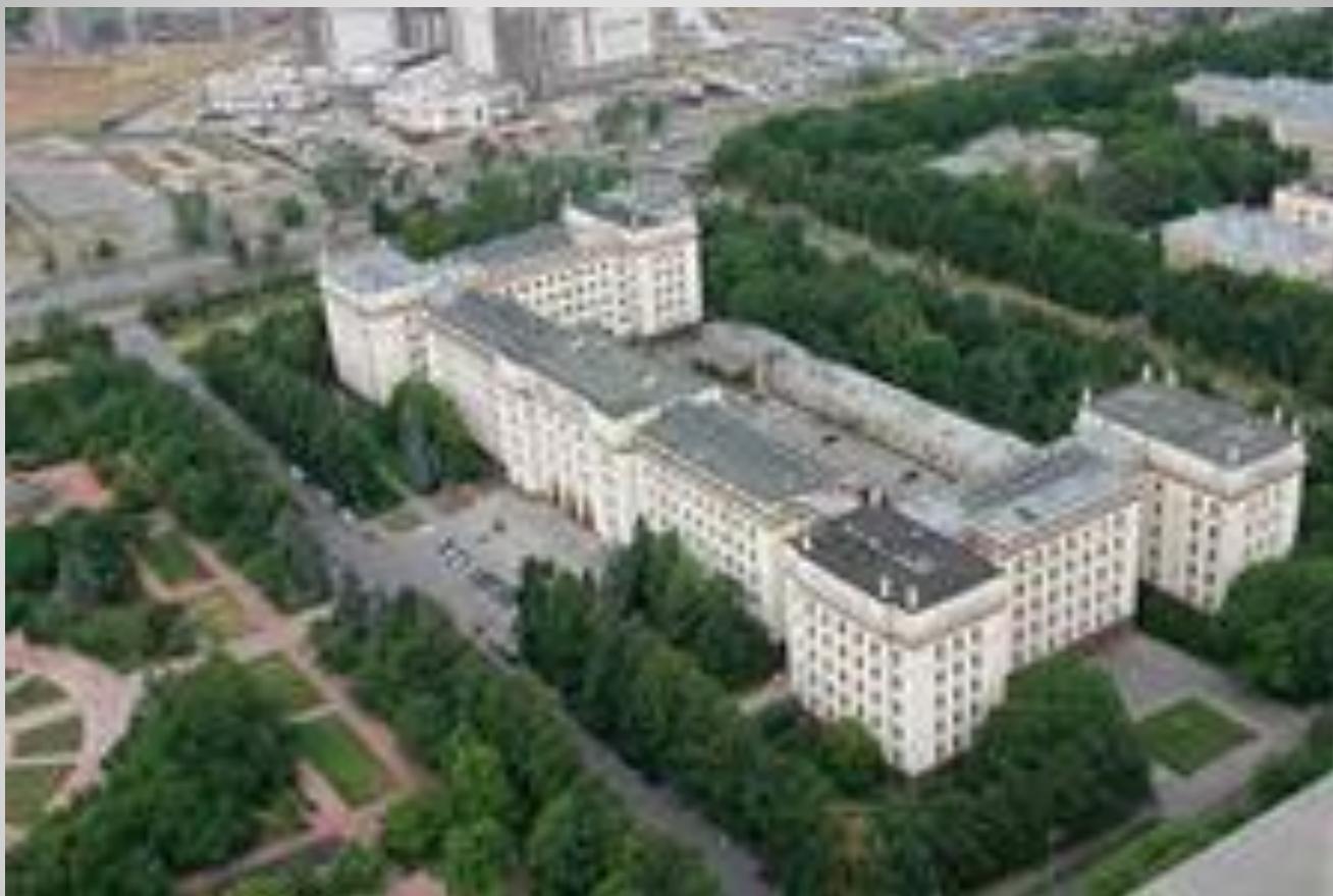
Химический корпус (здание ХФ МГУ)
