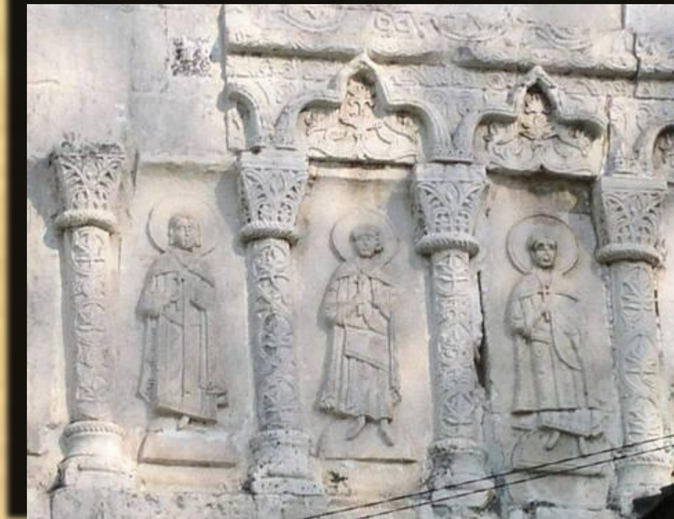
Георгиевский собор. Аркатурно-колончатый пояс
