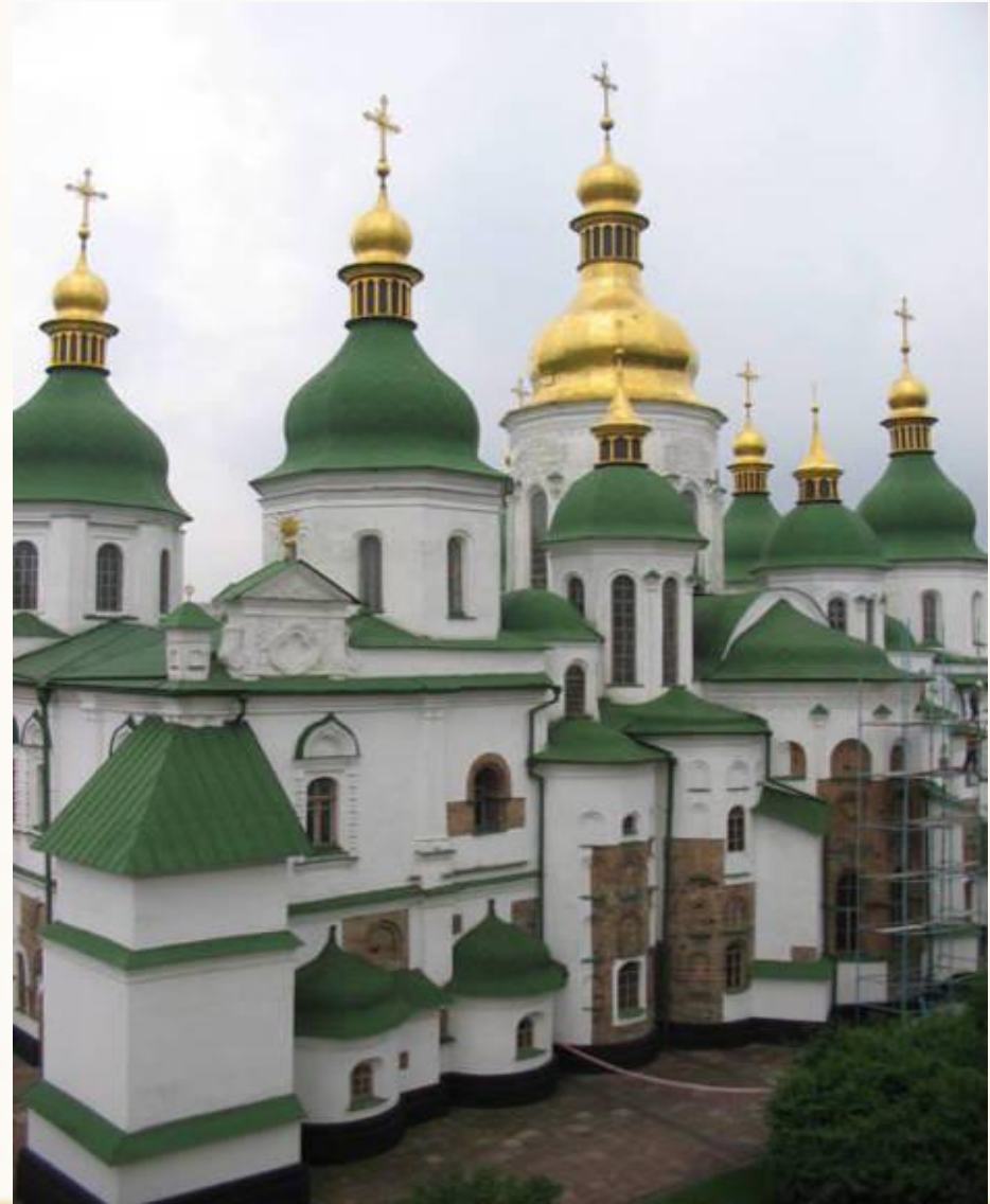
Вид собора с юго-восточного угла
