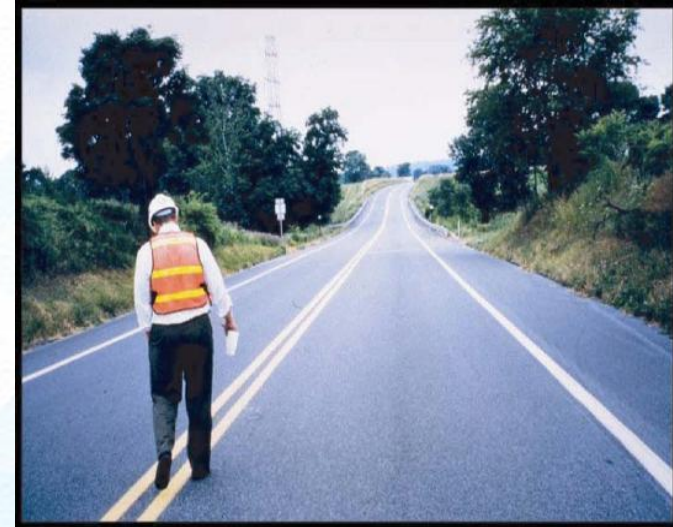
Визуальный контроль качества покрытия
