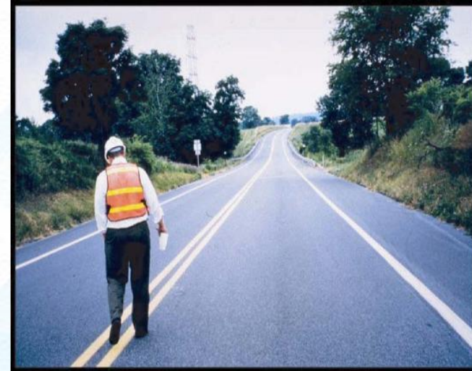
Визуальный контроль качества покрытия
