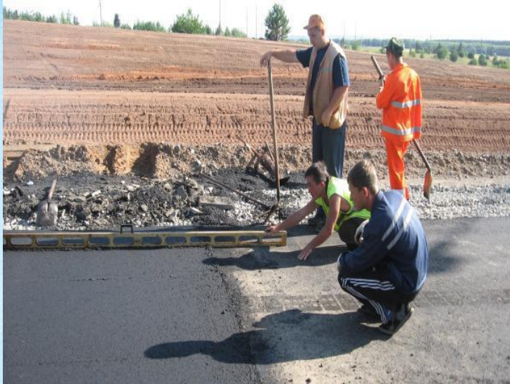
Контроль продольного уклона и ровности
